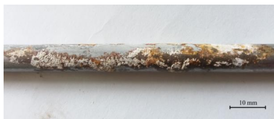
Slika 5. 7 Korozija armaturne šipke izvađene iz neisprskalih RAC uzoraka nakon 140 dana izloženosti 2% CO 2
