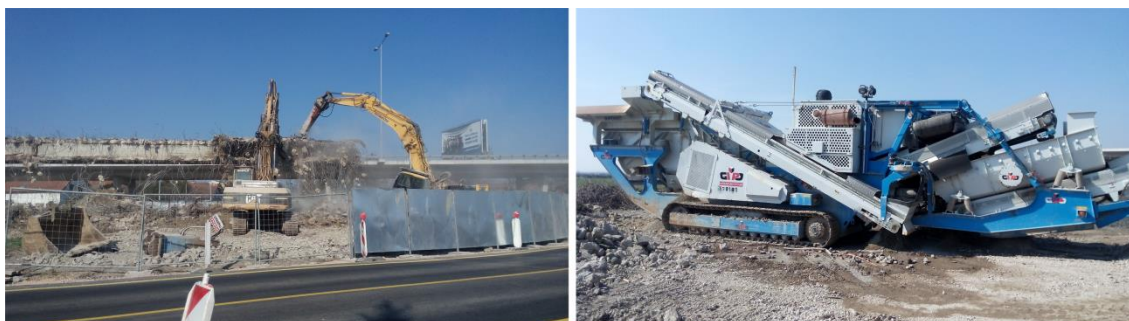
Slika 3. 5 Rušenje nadvožnjaka i drobljenje RA
