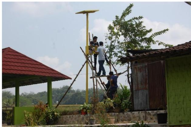
Gambar 7 Menginstall PLTS setelah ditegakkan
