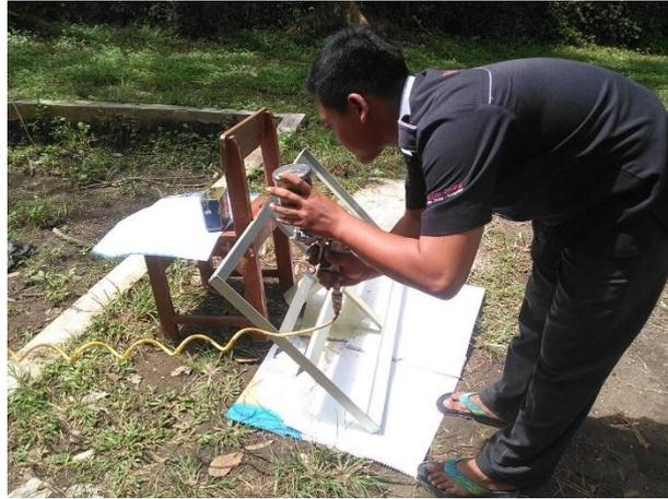
Gambar 3.2 Pengecatan kerangka untuk solar panel
