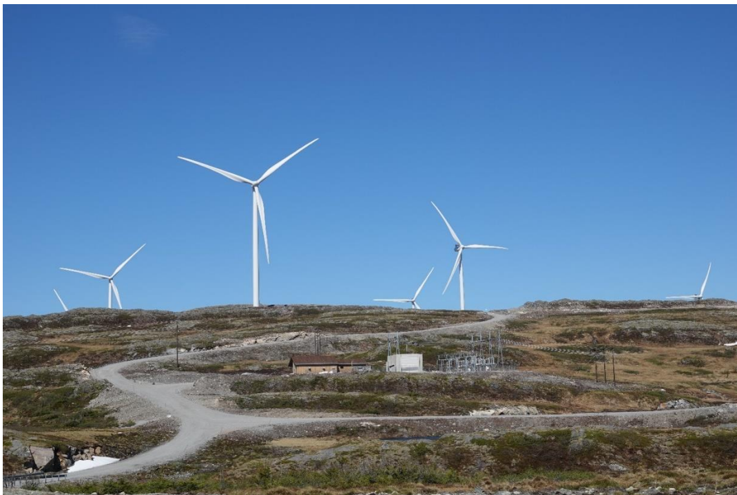
Bilde 2.1. Roan vindpark med veger, kraftstasjon, kraftlinjer og vindmøller i starten av juni 2020. Foto: Anita Husby
