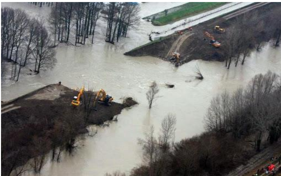
Fig. 7. A seguito delle piogge del gennaio 2014, il F. Secchia rompe l'argine destro in località San Matteo (MO), allagando un territorio di circa 200 km 2 e causando l'evacuazione di intere cittadine.
