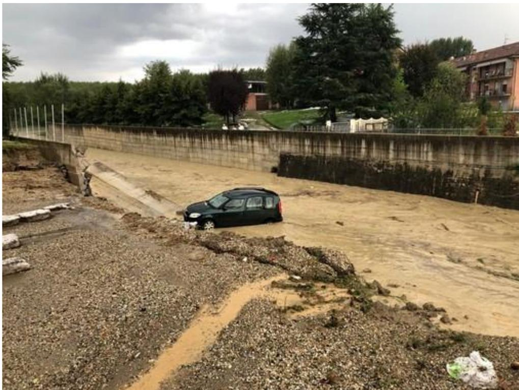
Figura 10 - Il muro crollato appena a monte della sezione 1 a seguito dell'evento meteorologico del 5 settembre 2019 (Rif. WEB n. 3).
