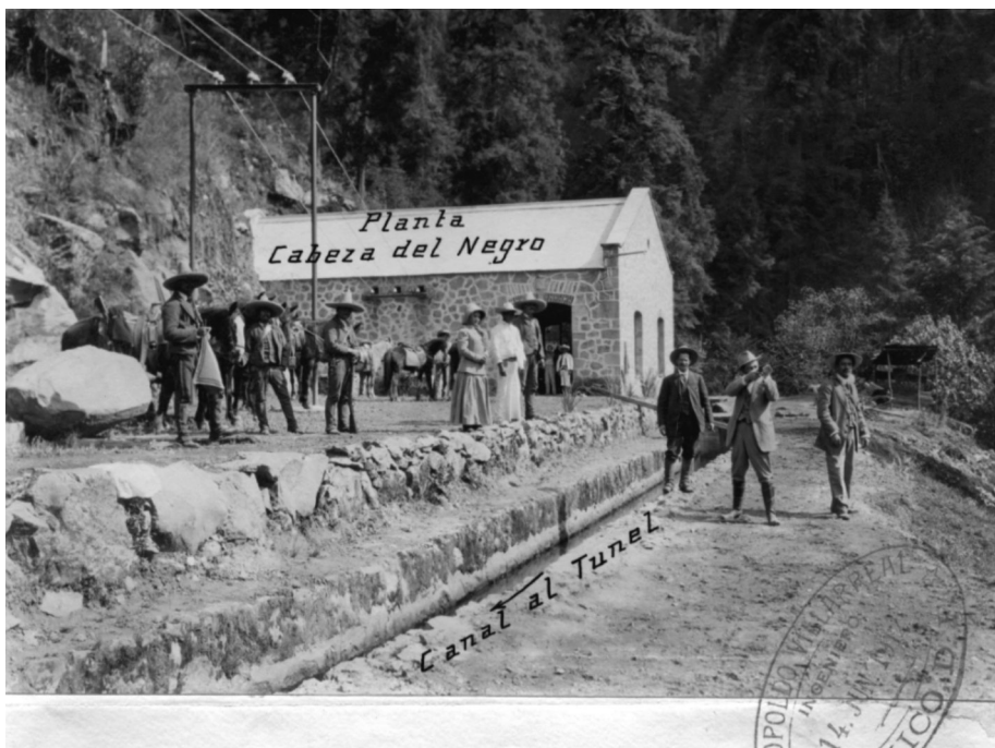
IMAGEN 2. PLANTA CABEZA DE NEGRO, QUE HACÍA USO DEL AGUA CONTENIDA EN LA PRESA DEL MISMO NOMBRE PARA GENERAR ENERGÍA MOTRIZ, CONVERTIDA DESPUÉS EN ELECTRICIDAD.
