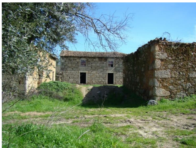
Figura 32.Vista de fora do Pátio (entrada)
