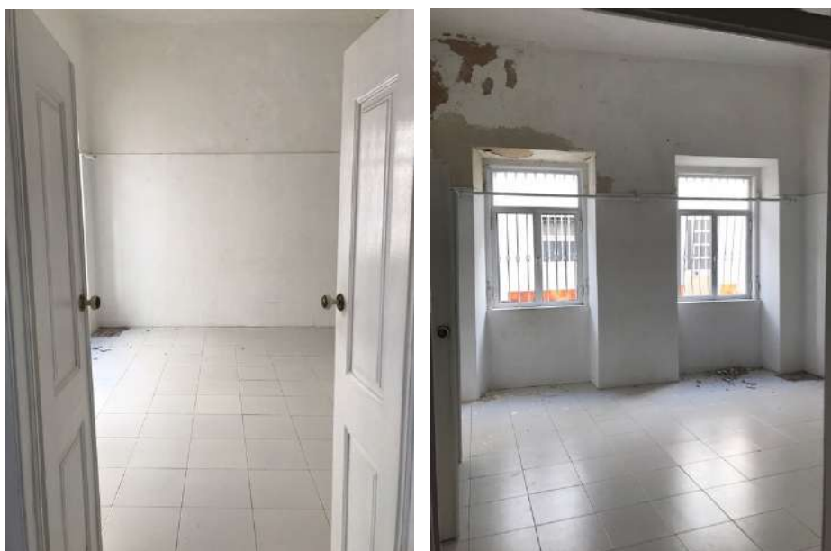
Figura 124 -Acesso à “casa de fora”, com portas originais da época. Figura 125 –Estado das janelas de alumínio pintadas de cor branca, é visível no canto superior esquerdo, os sinais de humidade.
