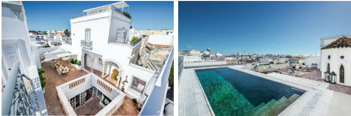
Figura 46 – Fotografia do espaço exterior renovado, são visíveis os diferentes “cubos” que compõem a casa.
