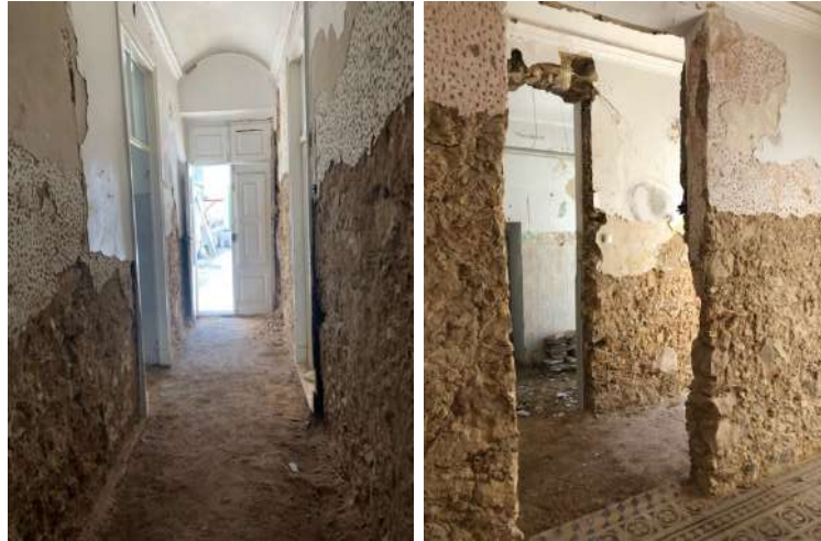
Figura 189 – Fotografias do corredor antes da remoção da parede da cozinha.
