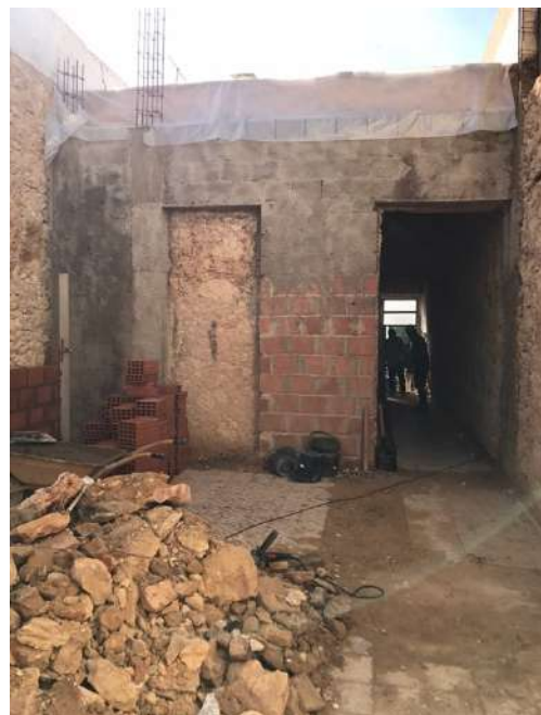
Figura 78 – Cozinha e sala de jantar, demolição da laje de cobertura. Figura 79 – Fotografia da sala sem cobertura. É possível verificar o espaço deixado pelas peças de mosaico retiradas para serem reutilizadas.
