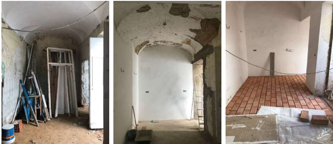
Figura 152 – Cozinha, fotografia na fase de demolições. Pode ser observado alguns dos aros de porta estragados. Figura 153 – Fotografia durante a primeira fase de rebocos. Figura 154 – Fotografia antes da construção da estrutura da cozinha durante a fase prévia aos acabamentos.
