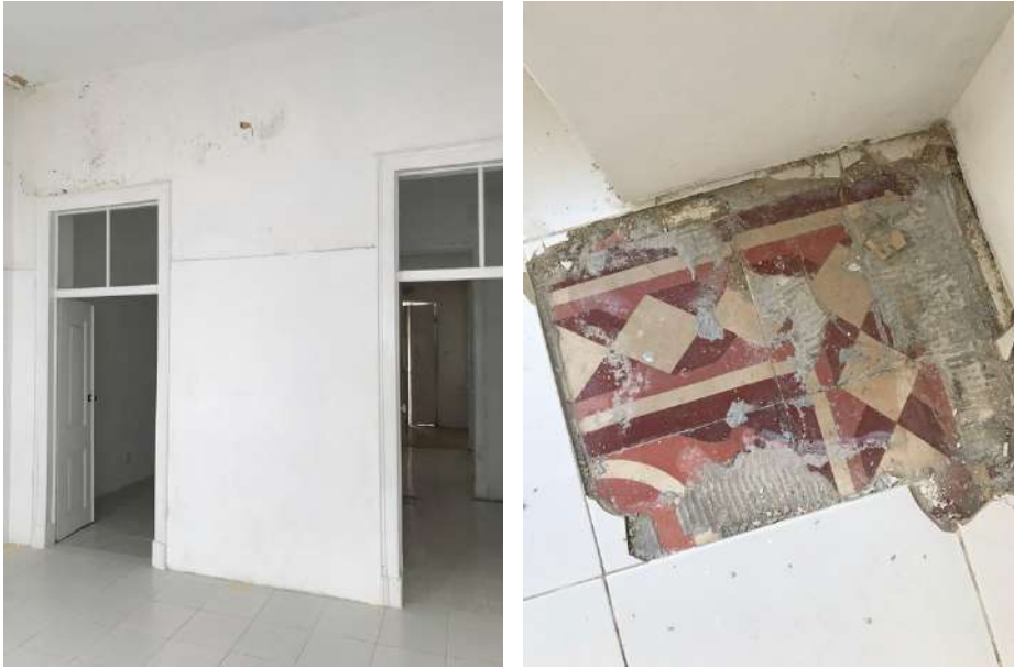
Figura 126 -Acesso bilateral, a divisão de apoio e ao hall de distribuição. Figura 127 – Teste efetuado ao pavimento existente para verificar a existência de mosaicos hidráulicos na habitação, porém, apesar de existirem, não foi possível a sua recuperação.
