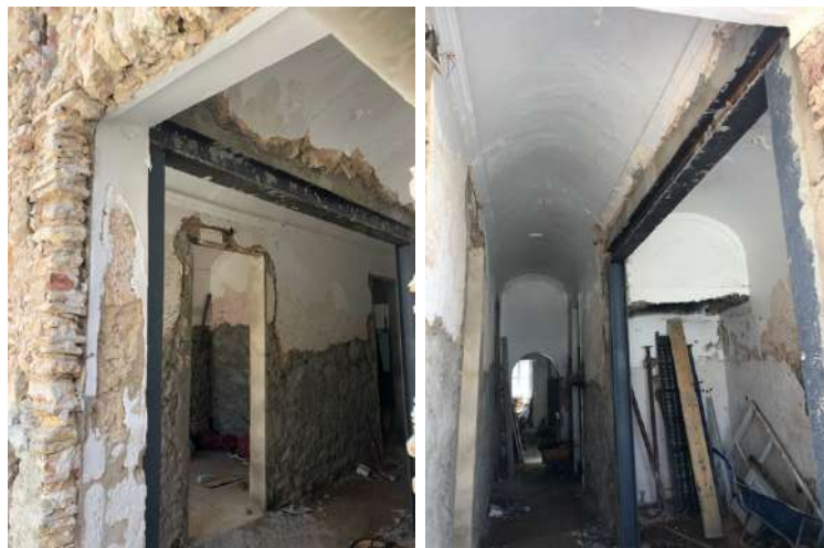
Figura 190 – Fotografia da estrutura metálica necessária para a abertura do vão da cozinha.
