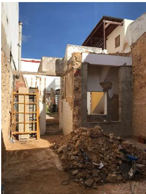
Figura 78 – Cozinha e sala de jantar, demolição da laje de cobertura. Figura 79 – Fotografia da sala sem cobertura. É possível verificar o espaço deixado pelas peças de mosaico retiradas para serem reutilizadas.
