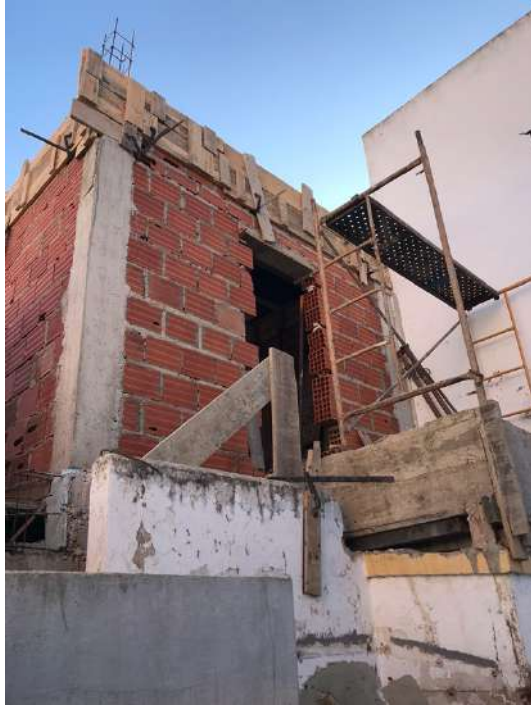
Figura 82 – Fotografia do processo de construção da nova ampliação da cobertura, vista desde a escada de acesso. Figura 83 - Fotografia da fachada frontal da ampliação. É possível visualizar o espaço restante que será preenchido com betão leve para evitar sobrecargas na estrutura inferior
