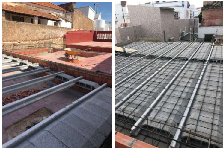
Figura 192 – Fotografia da nova laje, durante a fase de execução.
