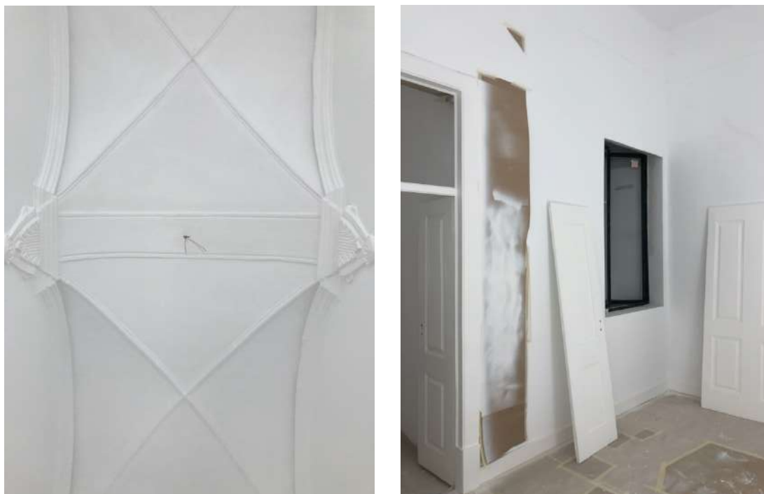
Figura 200 – Fotografia do teto do corredor e da primeira divisão, a sala.
