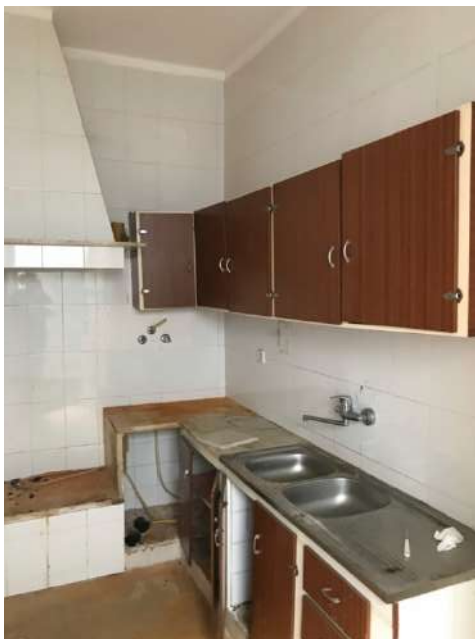
Figura 97 – Cozinha em alvenaria com pormenores tradicionais, entre eles a saída de fumo e a estrutura baixa. Figura 98 – Acesso à cozinha através da porta do pátio. Esta foi alterada para evitar a entrada de águas pluviais.
