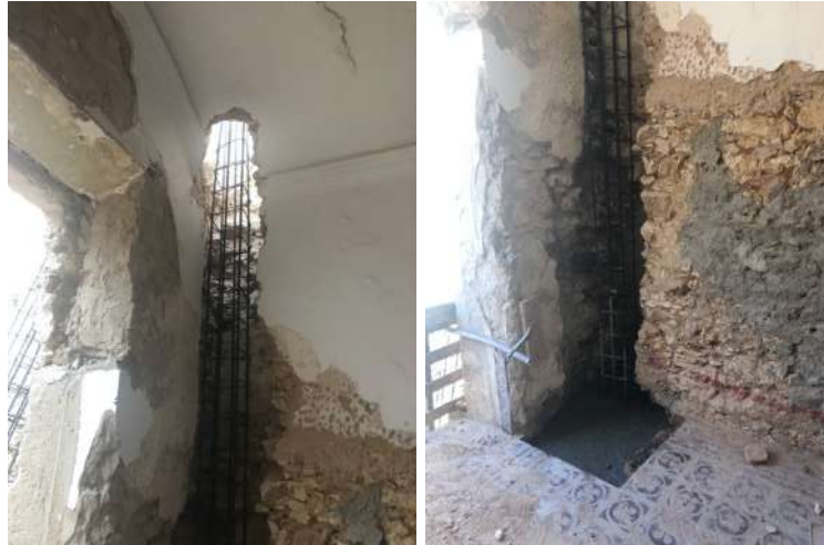
Figura 191 – Fotografia dos pilares de suporte da nova laje.
