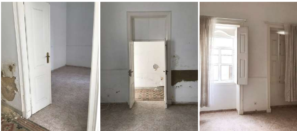
Figura 171 – “Casa de fora”, acesso através do corredor de entrada, apresenta o estado das paredes e o pavimento descaracterizado. Na última imagem é possível observar a mudança de material nas janelas mantendo as portadas originais.
