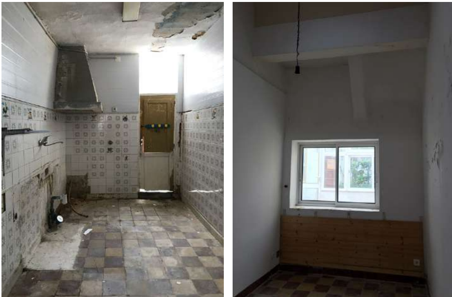
Figura 64 – fotografia da cozinha. Apresenta ainda a saída de fumo tradicional, mas construída em cimento. Figura 65 - Fotografia da sala de jantar.
