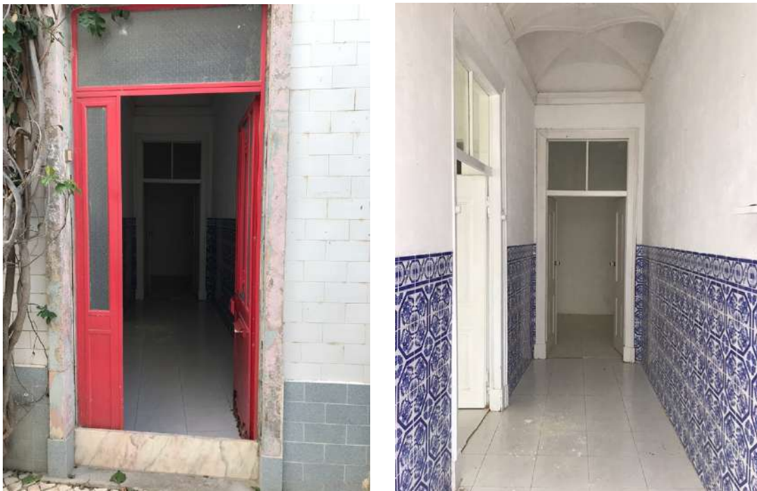
Figura 122 -Porta de acesso à habitação. Figura 123 – Corredor de entrada. À esquerda encontra-se a “casa de fora” e ao fundo o hall de distribuição.
