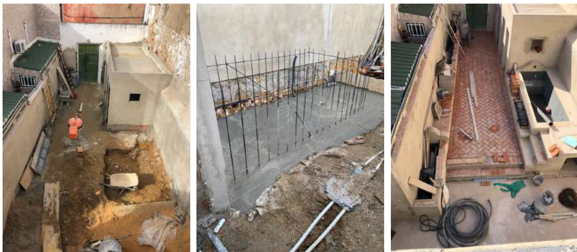
Figura 194 – Fases de construção do tanque, desde as escavações, construção das fundações e antes dos revestimentos, já impermeabilizada no interior.
