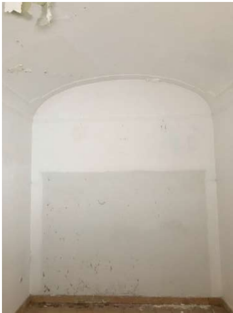
Figura 95 – Parede da sala de jantar que apresenta humidade ascendente. Figura 96 – Fotografia do vão existente na sala de jantar.
