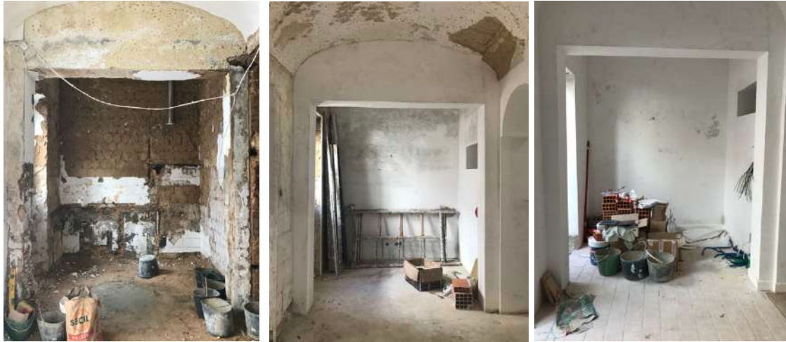
Figura 149 – Sala de estar, Fotografia na fase de demolições. Figura 150 – Fotografia durante a primeira fase de rebocos. Figura 151 – Fotografia durante a fase previa aos acabamentos.
