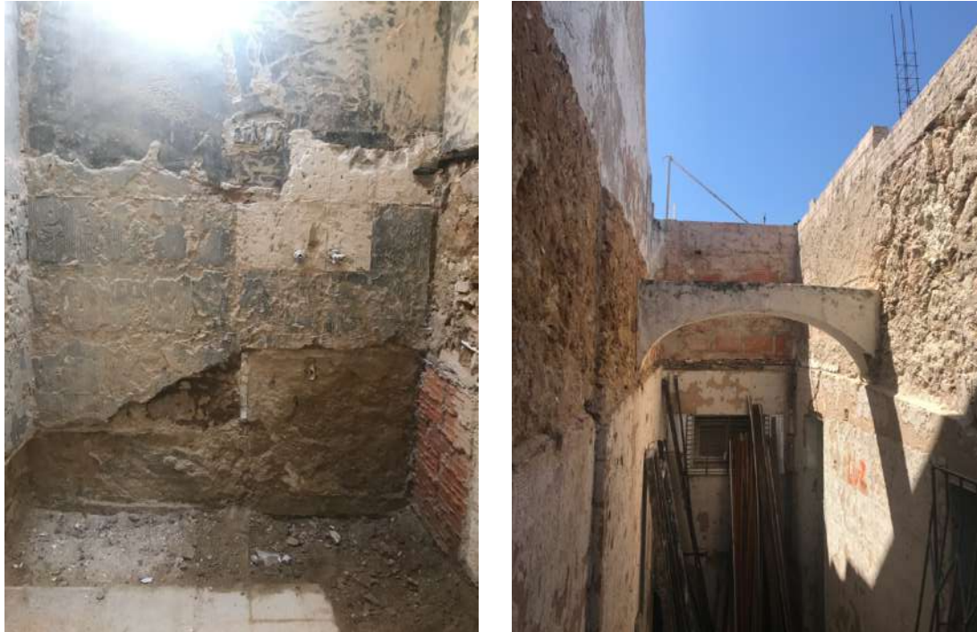
Figura 112 – Fotografia das paredes da antiga cozinha, a ser preparada para a criação da nova instalação sanitária. Figura 113 - Fotografia do pátio lateral, sem revestimentos e elementos de sombreamento.
