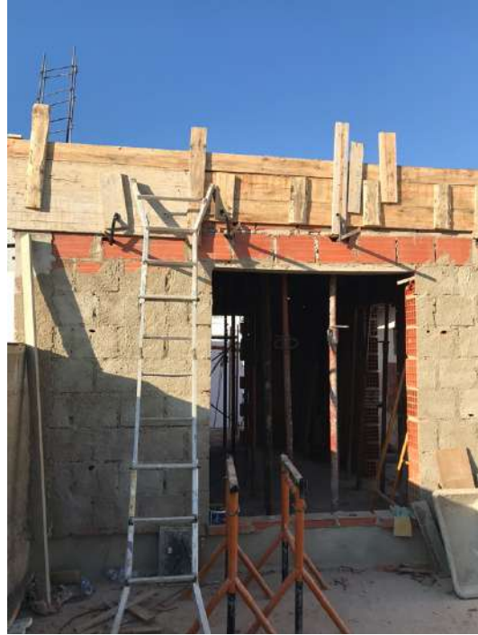
Figura 82 – Fotografia do processo de construção da nova ampliação da cobertura, vista desde a escada de acesso. Figura 83 - Fotografia da fachada frontal da ampliação. É possível visualizar o espaço restante que será preenchido com betão leve para evitar sobrecargas na estrutura inferior
