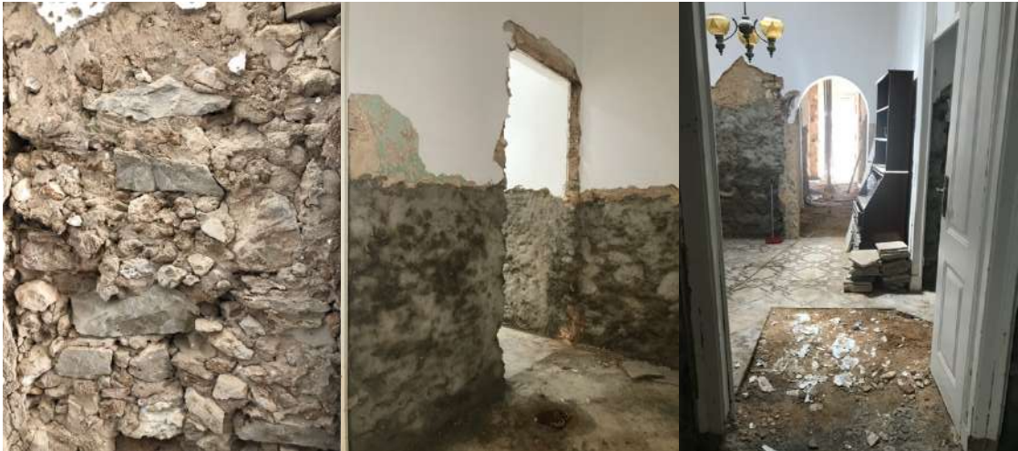
Figura 184 – Fotografias do Hall, onde é possível observar a parede antes de aplicar a argamassa consolidante. É possível observar o pavimento que foi removido para conservação.
