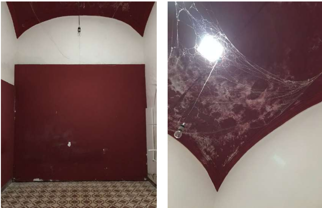
Figura 60 – Vista do quarto de apoio. Figura 61 - Vista do teto abobadado e das paredes em gesso cartonado pintado de cor encarnada, apresenta sinais de salitre
