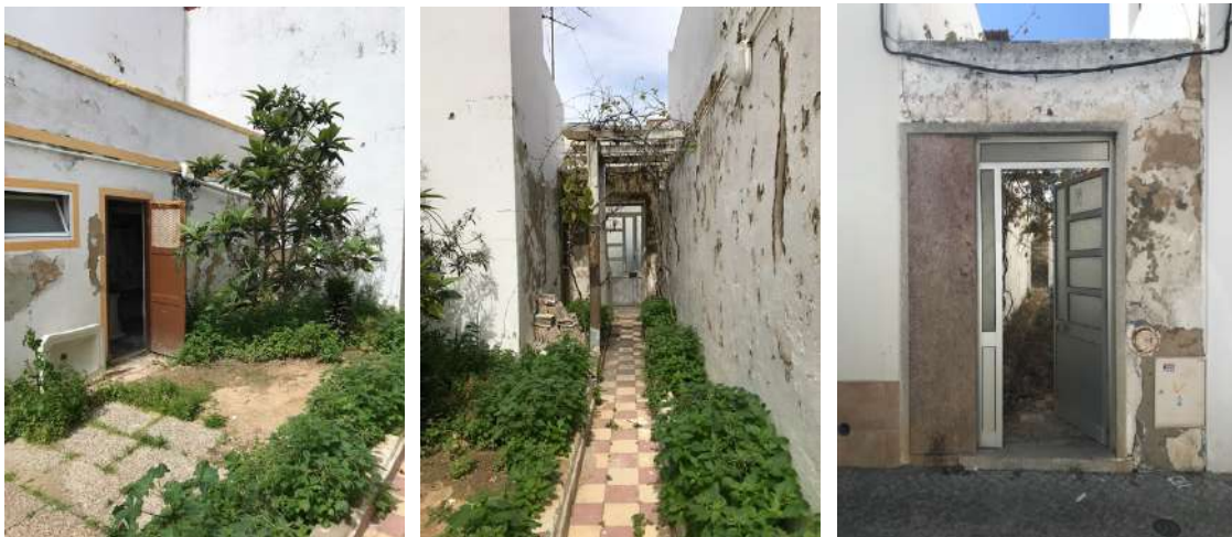
Figura 67 – Fotografia dos acessos do anexo existentes no Pátio. Figura 68 – Corredor de acesso tardoz. Figura 69 – Fachada existente na rua Joaquim Ribeiro.
