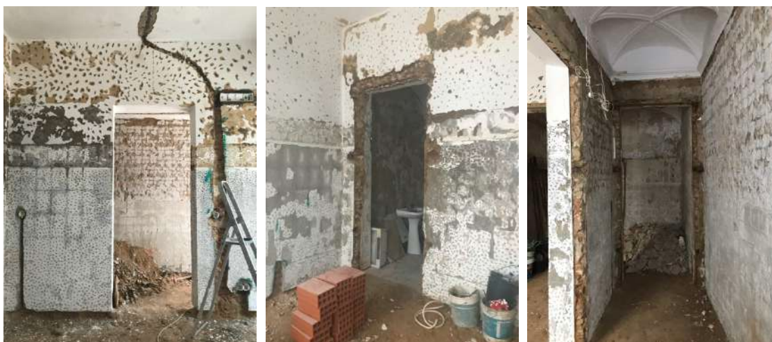
Figura 143 – “Casa de Fora”, é possível observar a previa existência de azulejos na parede. Figura 144 – Acesso ao quarto 1, após a remoção da porta de acesso através da “casa de fora”. Figura 145 – Corredor de acesso após a remoção dos revestimentos. O teto foi preservado com o maior cuidado para ser restaurado numa fase final.
