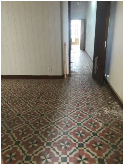
Figura 76 – Fotografia da sala antes do início dos trabalhos. Figura 77 – Fotografia da sala após a remoção das placas plásticas de revestimento e mosaico hidráulico.
