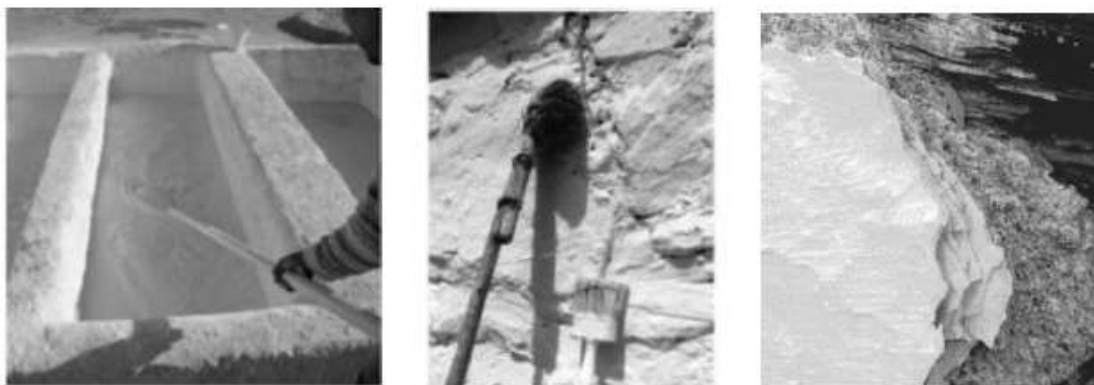
Figura 26 – Preparação de cal, ferramentas utilizadas em aplicação
