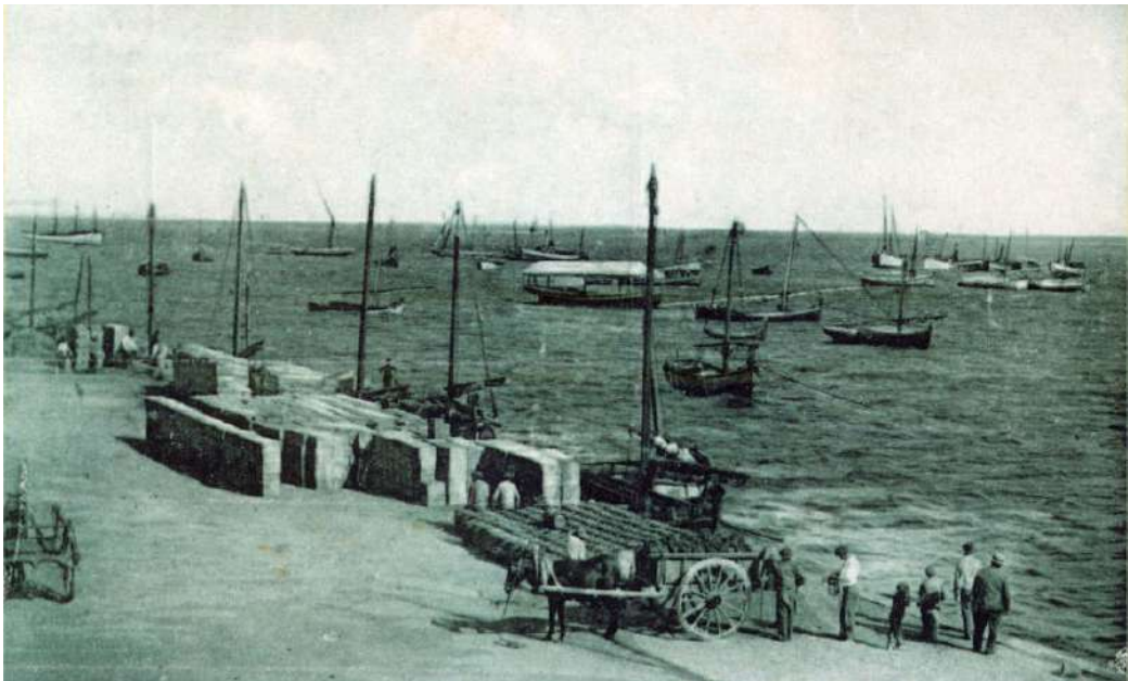
Figura 20 - Trecho do porto de pesca de olhão, década de 1900 – Antes da expansão
