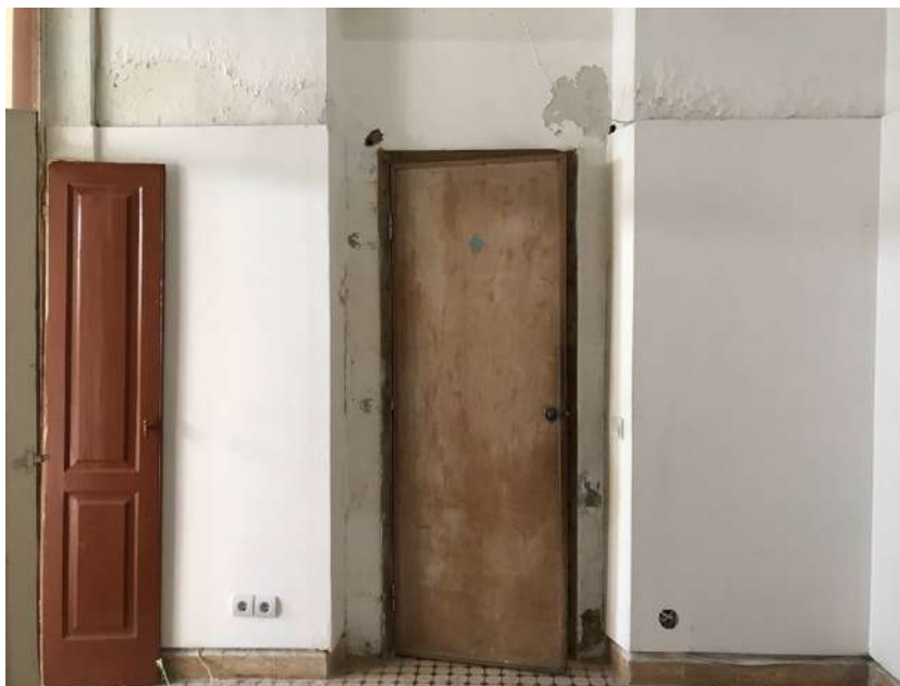
Figura 59 – Fotografia da porta de acesso à segunda divisão. Arranjos temporários permitem visualizar os sinais de salitre.
