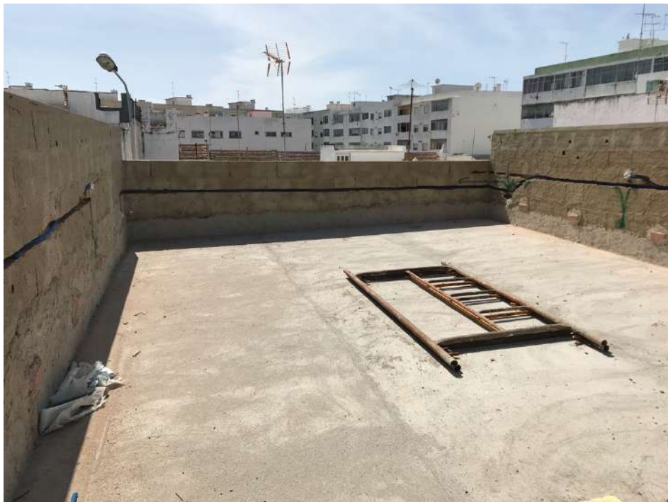
Figura 84 – Espaço restante da açoteia que será nivelado e preenchido com betão leve e posteriormente instalado pavimento tradicional de Sta. Catarina.
