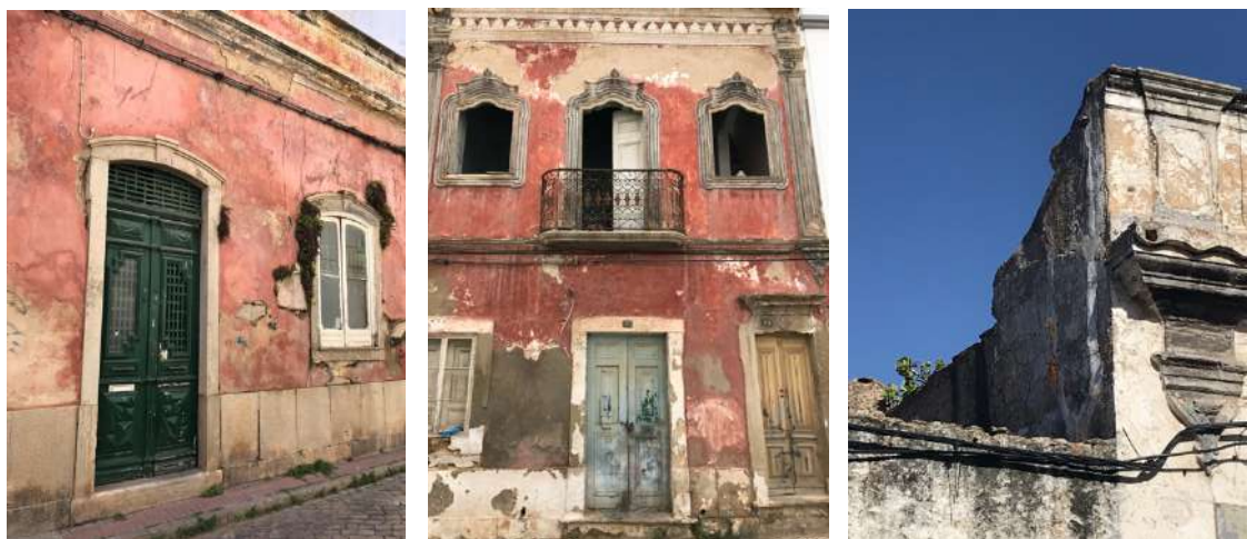
Figura 35. Fachada na rua dr. Miguel Bombarda; Figura 36. Fachada na rua de São José; Figura 37. Fachada na rua Serpa Pinto.
