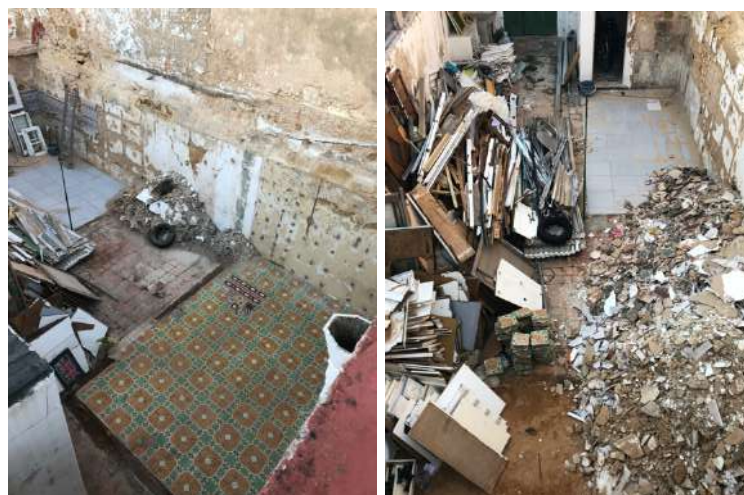
Figura 193 – Fotografia durante a triagem de materiais no pátio.
