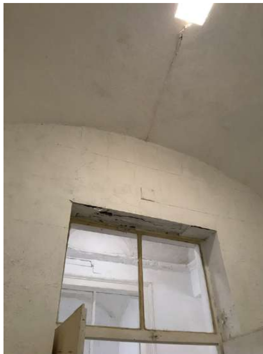
Figura 132 - Vista completa do corredor central desde a sala. Figura 133 – Teto abobadado do quarto de arrumos, deteriorado pela humidade. É possível ver o alastramento da água até as madeiras da porta.
