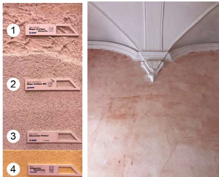
Figura 195 – Fotografia das diferentes camadas aplicadas. Figura 196 – Fotografia da parede do corredor antes das últimas camadas de produto a serem aplicadas.
