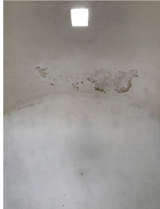
Figura 130 - Vista completa do quarto, desde a porta de acesso da “casa de fora”. Figura 131 – Teto abobadado do quarto, deteriorado pela humidade.
