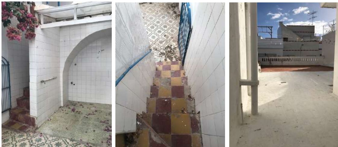
Figura 137 – Fotografia do pátio e arco baixo as escadas. Figura 138 – Fotografia do lanço de escadas estreito que permite o acesso até a açoteia. Figura 139 – Fotografia da açoteia, desde o fim das escadas.
