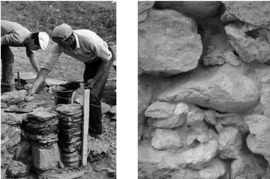
Figura 52 – Preparação de estrutura em alvenaria, materiais utilizados.
