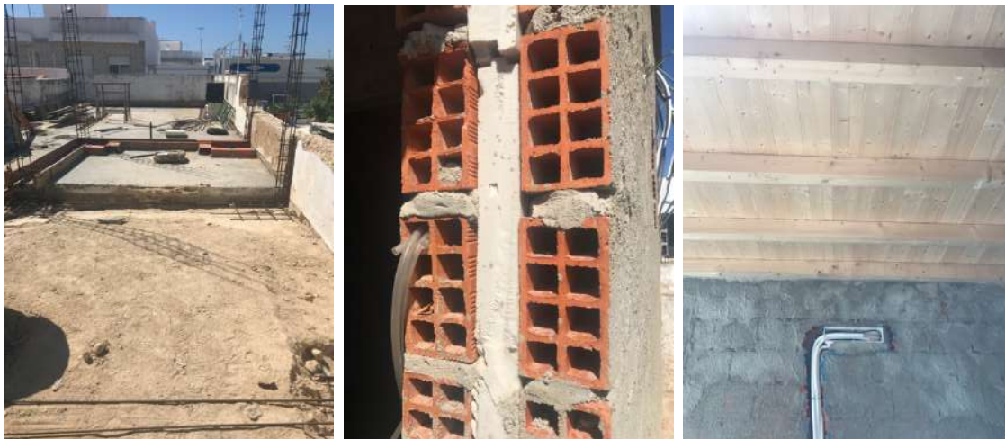
Figura 114 – Processo de construção do anexo, durante armação dos pilares. Figura 115 – Instalação de novas camadas de isolamentos térmicos. Figura 116 - Acabamento interior revestido no teto em madeira, sendo apenas um efeito visual, já que a estrutura foi efetuada em betão armado.
