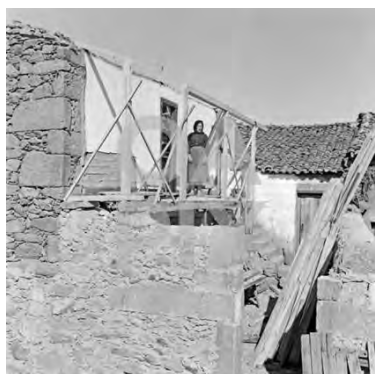
Figura 6 Construção de uma varanda, Fundão (Fonte: http://www.oapix.org.pt/100000/1/1699,01,3/index.htm )
