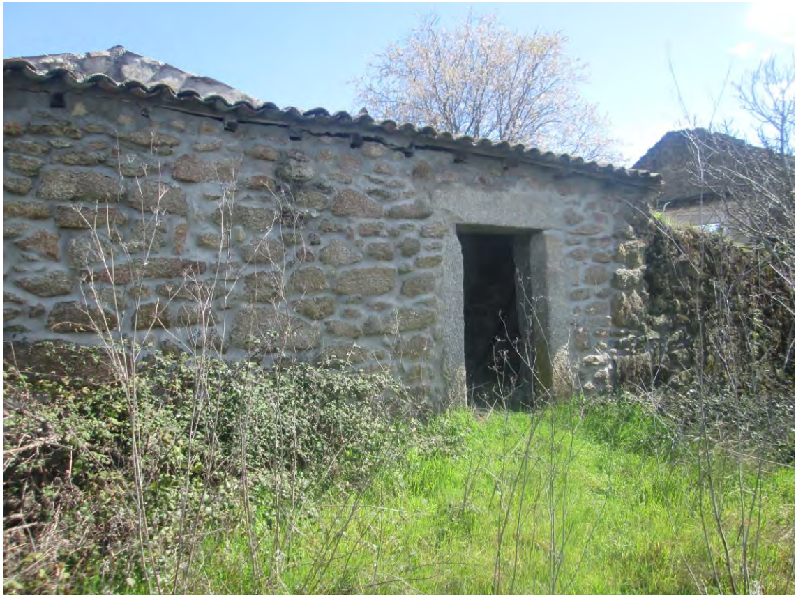
Figura 38 Aspeto exterior da casa do Forno (Fonte: própria autoria)
