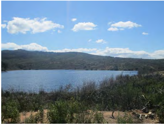
Figura 18 A barragem (Fonte: própria autoria)
