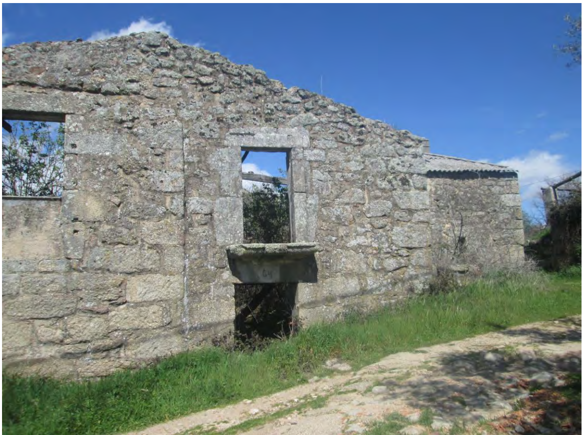
Figura 37 Vista frontal da Casa do Feitor (Fonte: própria autoria)
