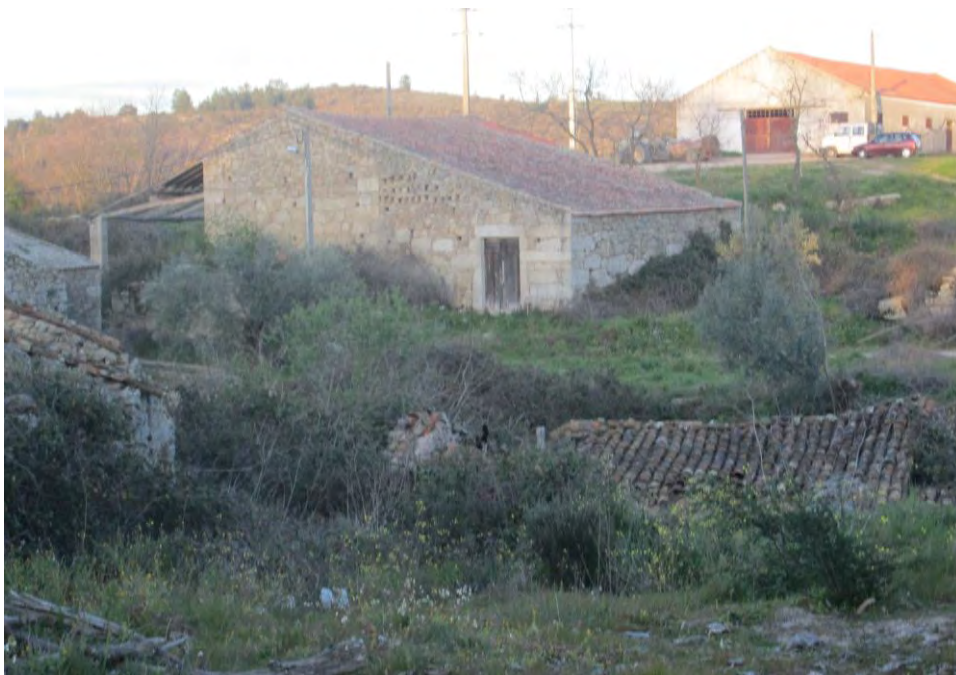
Figura 33 Vista frontal da Adega ou “Tulha” (Fonte: própria autoria)
