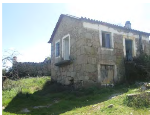
Figura 42 Vista de Habitação (33) (Fonte: própria autoria)
