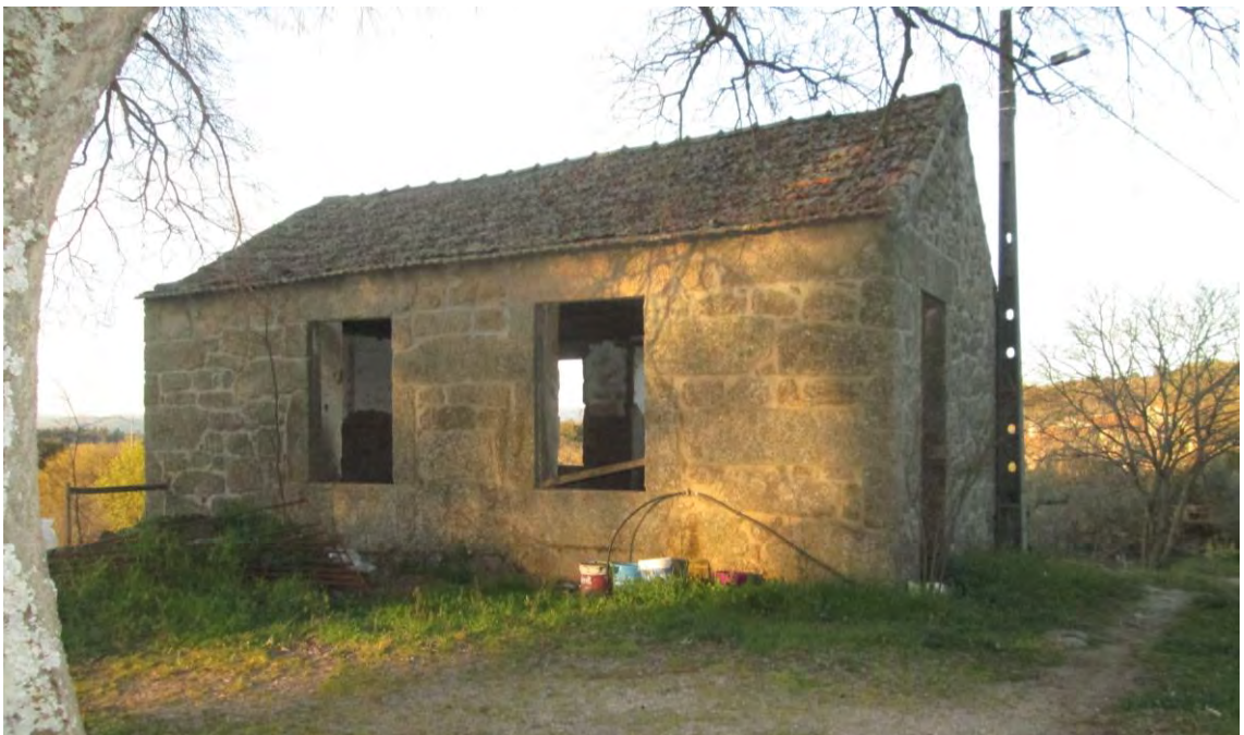
Figura 35 Vista da Escola (Fonte: própria autoria)
