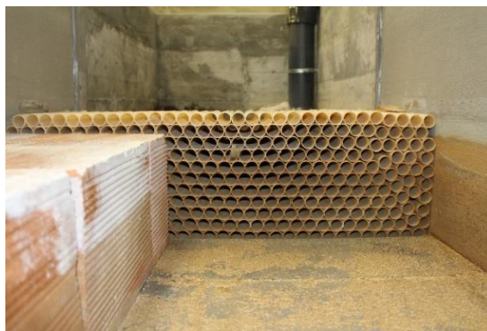
Figura 3.4: Entrada do canal, vista de jusante
