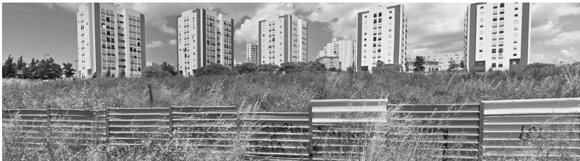
Figura 9 - Local de intervenção vista a partir da Rua Mário Botas
