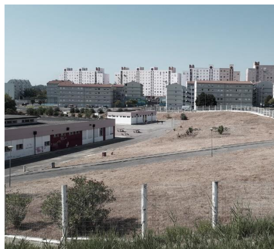
Figura 6 - Blocos de habitação e escola Básica de Marvila
