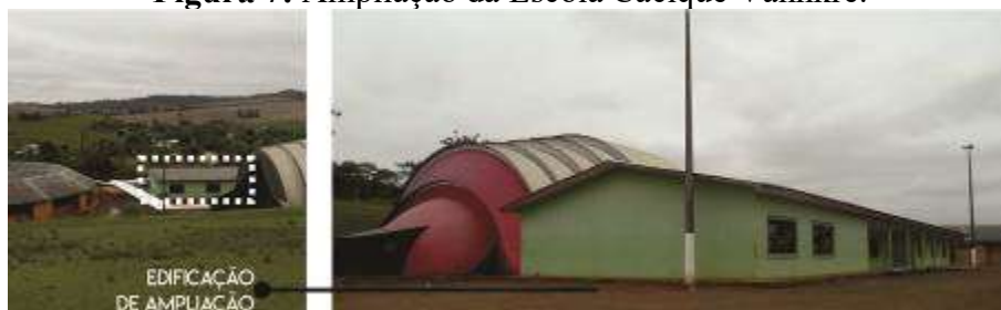
Figura 7: Ampliação da Escola Cacique Vanhkre.
