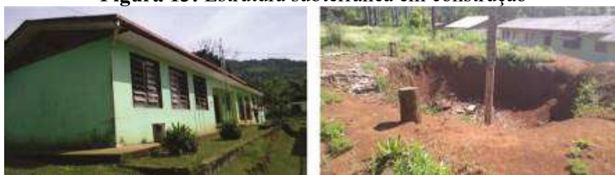
Figura 13: Estrutura subterrânea em construção
