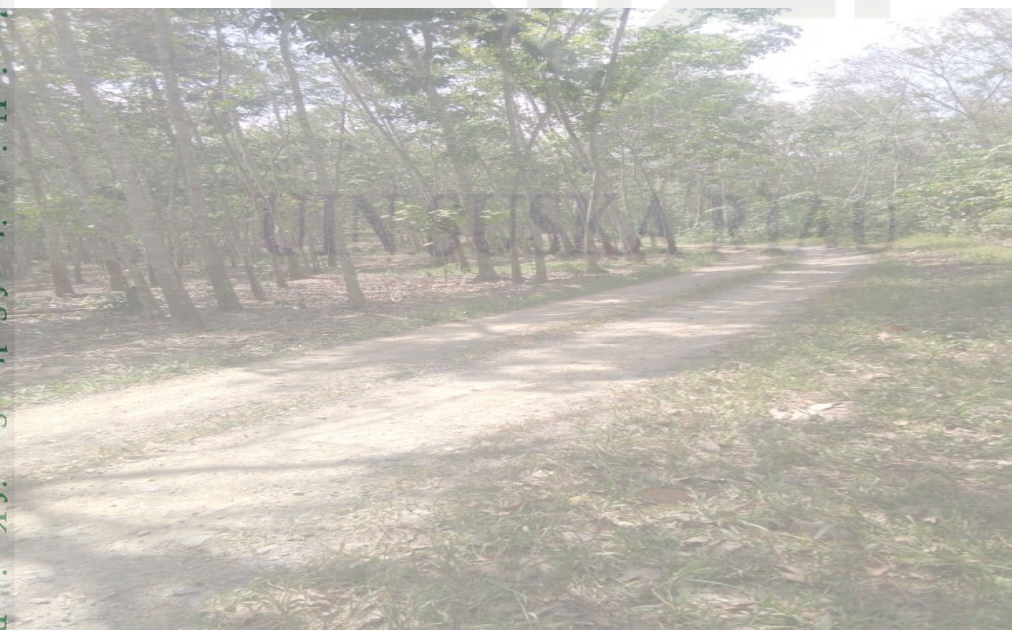
Gambar 8.2 kondisi infrastruktur jalan desa yang telah diperbaiki
