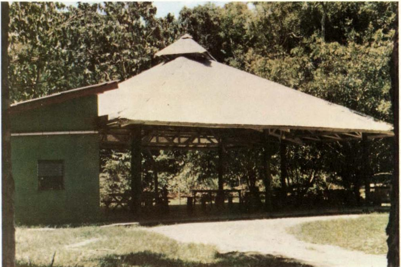
Fig. 5 — Vista da cantina dos trabalhadores da EEST.
