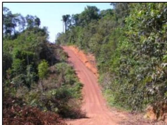
**FOTO 02** – Ramal interno no PA Uatumã, cascalhado e em boas condições de trafegabilidade.
