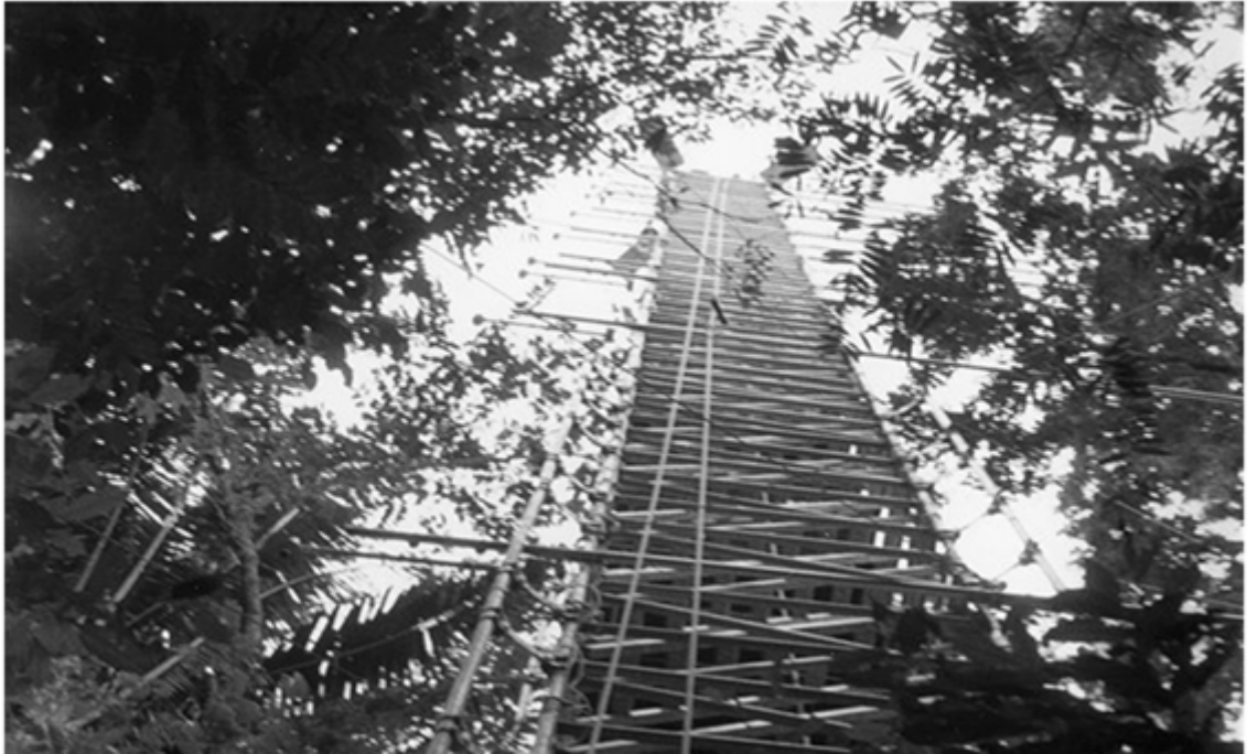
Figura 2.2.1 Fotografia da torre micrometeorológica de 60 m de altura construída na Rebio-Jarú. Fonte: Dias Júnior, 2008.
