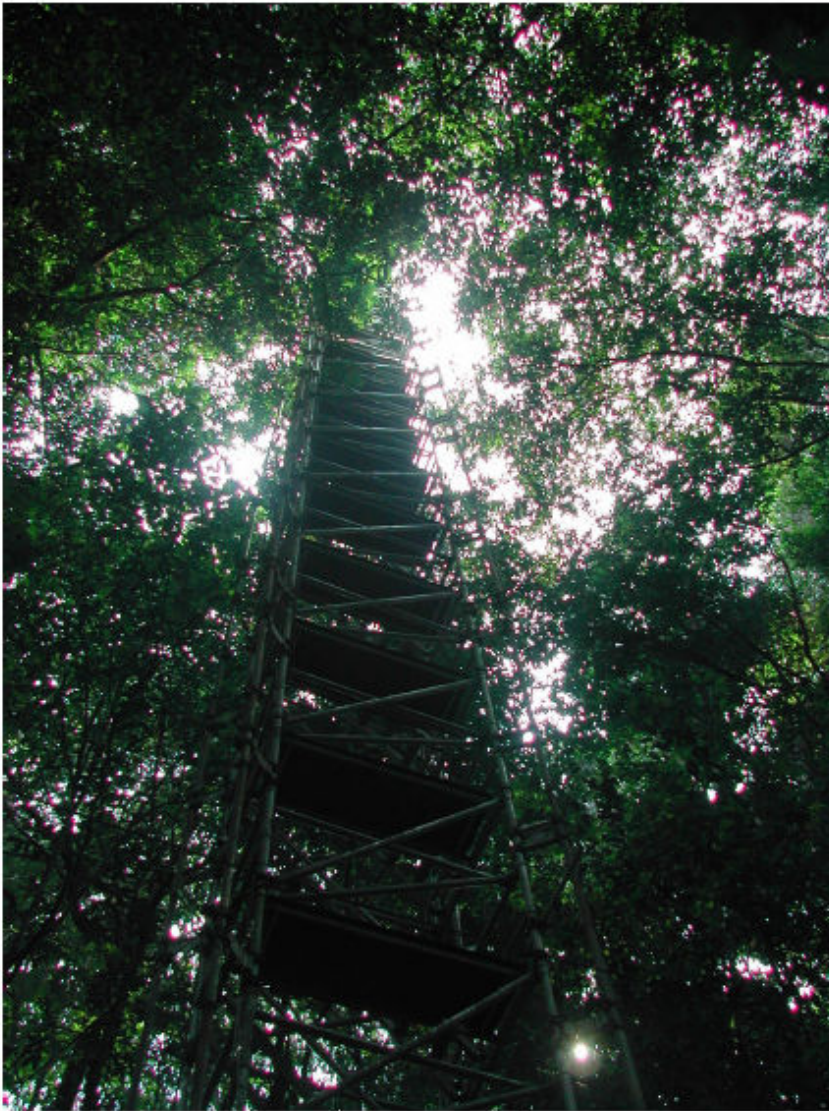
Figura 2.3.2 Torre micrometeorologica de 55m, instalada no interior da floresta de Caxiunã.
