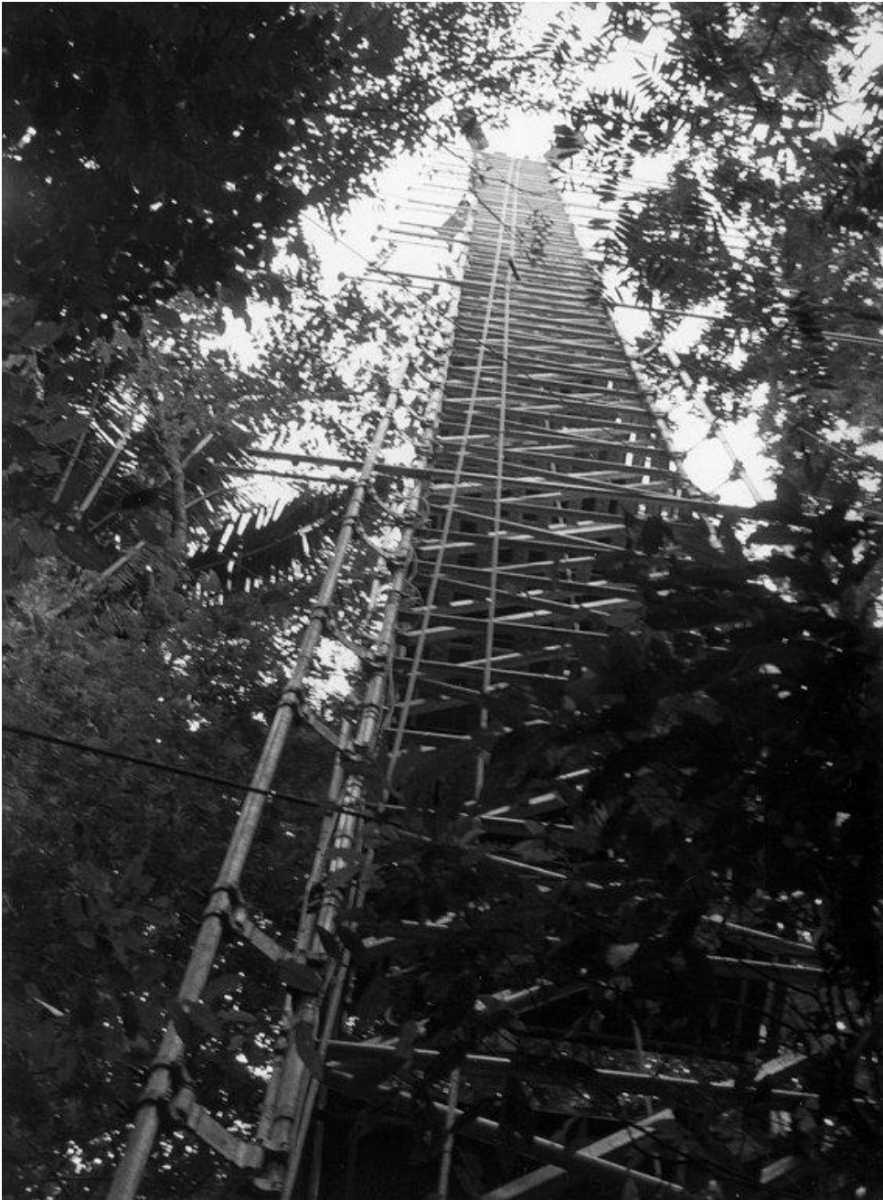
Figura - 3.2 Foto mostrando a torre de 60 m de altura construída na Rebio Jarú, em Rondônia. Fonte: Dias Júnior, 2008.
