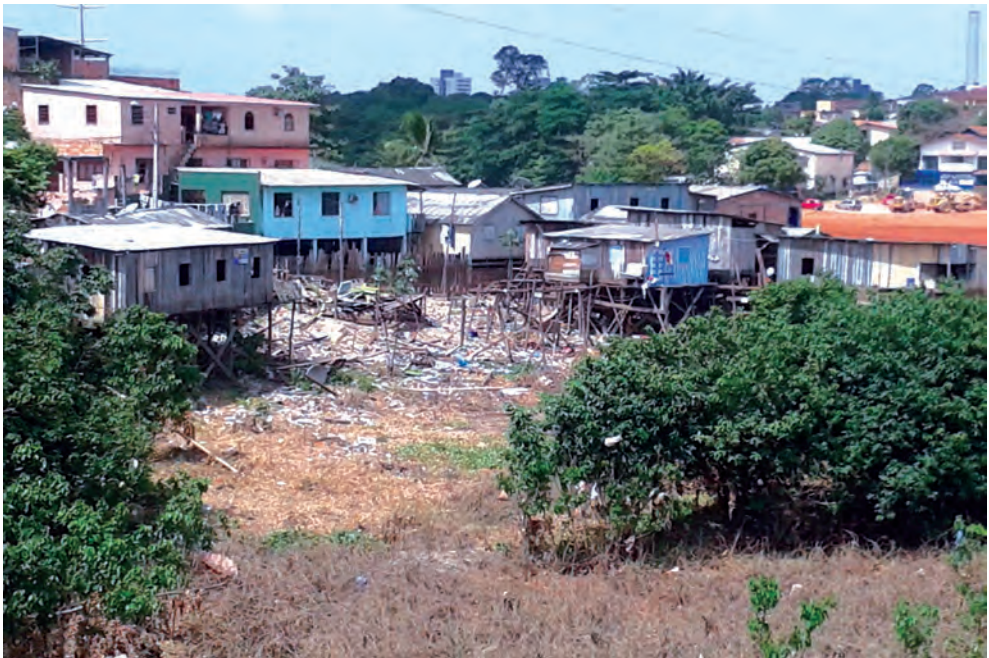
Figura 02 - Moradias Palafíticas no bairro de São Jorge. Tais moradias continuam ocupadas, há o auxílio da Operação SOS Enchente realizada pela Prefeitura Municipal de Manaus, que tem “benefícios” como o aluguel social e, eventualmente, água potável, rede, lençol, colchão e cesta básica para os afetados pela cheia. Fonte: BELEZA, M.C; 2015.
