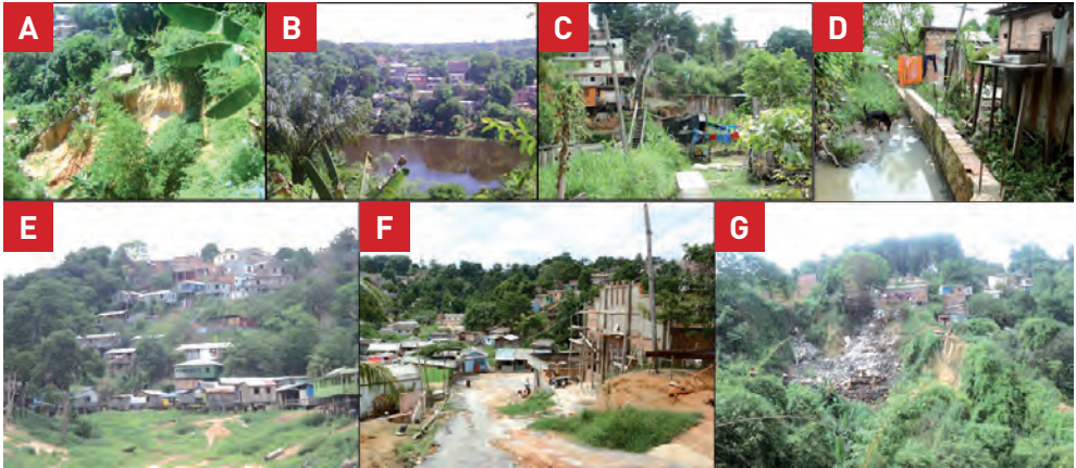
Figura 27 - Situações de risco da Bacia Hidrográfica do Mauzinho. A – Risco por voçorocamento; B – Área de proximidade com a ria, com visualização das encostas; C – Precariedade na acessibilidade; D – Condições de insalubridade; E – Área de risco de deslizamento e inundação com visão das residências palafíticas no baixo; F – Problemas urbanos como a falta de recapeamento asfáltico adequado; e G – Resíduos sólidos em voçoroca com residências em seu entorno. Fonte: MACENA, L.S.L. (2012).
