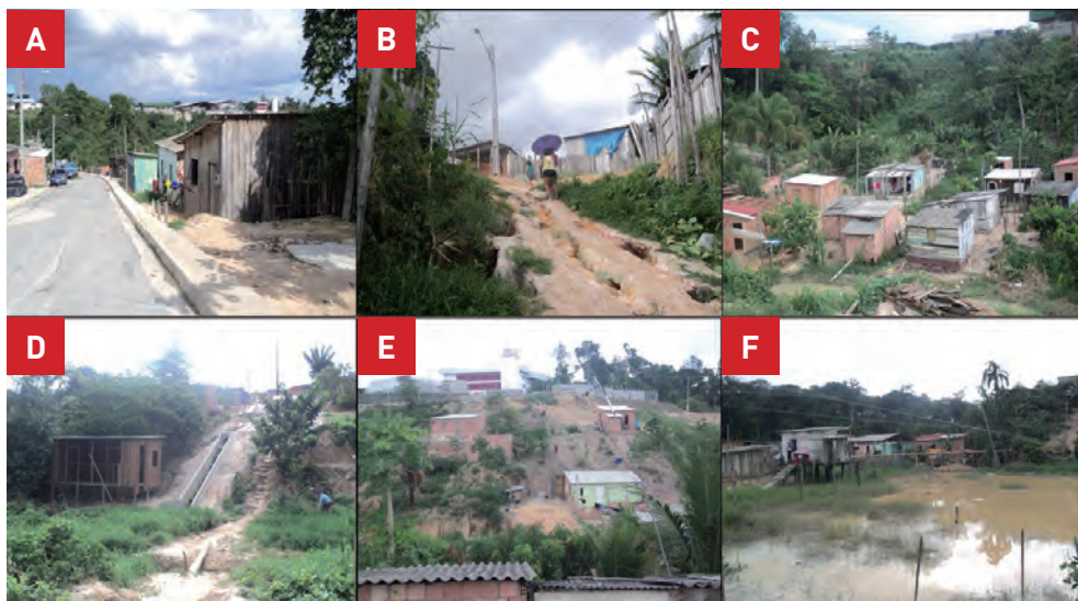
Figura 17 - Comunidade Nova Vitória, bairro Gilberto Mestrinho. A – Indica a comparação da rua com asfalto com B – Que apresenta falta de asfalto e erosão linear; C e F – casas em áreas alagáveis; D – as obras mau-executadas; e E – vulnerabilidade a deslizamentos. Fonte: Acervo LAES (2010), org. MACENA, L.S.L.
