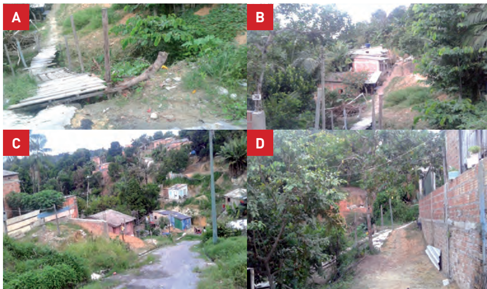
Figura 16 - Comunidade Grande Vitória, bairro Gilberto Mestrinho, BHCAA. A – Ponte precária sobre igarapé e corte no talude; B – Uma das vertentes semi florestada do bairro; C – Encosta declivosa ocupada, cujas moradias são de alvenaria e via asphaltada; e D – Construção e corte no terreno com solo exposto, exemplos de vulnerabilidade, riscos e fragilidades ambientais urbanas.
