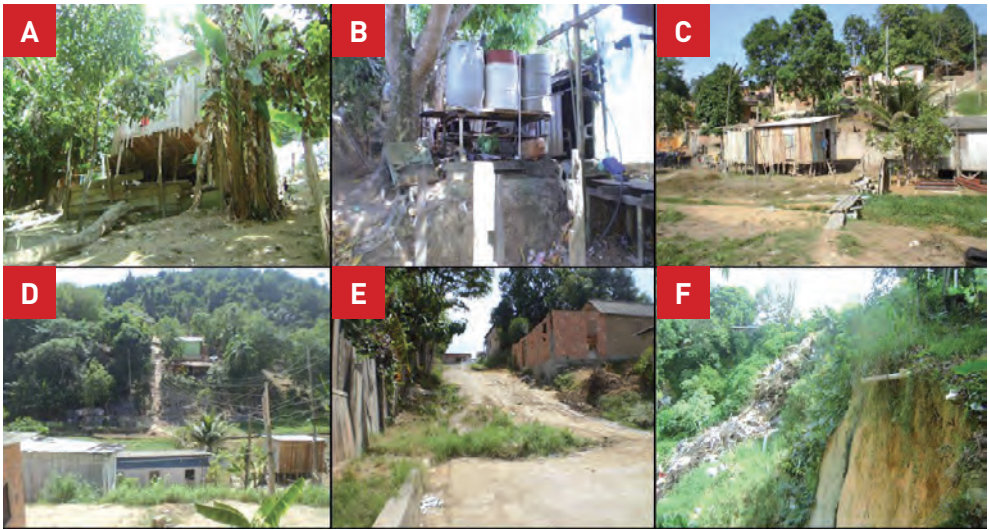
Figura 23 - Situações de risco na Comunidade João Paulo II, Jorge Teixeira – BHP. A – Construção de madeira irregular em encosta; B – Precariedade na distribuição do serviço de água encanada; C – Moradias no fundo do vale, próximas ao igarapé, que também serve de esgoto; D – Interflúvios identificando o solo exposto nas vertentes, potencializador dos processos erosivos; E – Problemas no recapeamento asfáltico e; F – saída do emissário em voçoroca, cuja lateral está recoberta por resíduos sólidos, que exercem peso na encosta, potencializando deslizamentos. Fonte: Acervo LAES (2011), org. MACENA, L.S.L.
