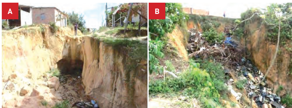
Figura 08 - Ravinamento gerado a partir da exposição do solo as chuvas e a falta de infraestrutura viária em (A) e voçorocamento em terreno bastante inclinado, nota-se uma lixeira viciado no local em (B). Foto: Tiago F. Rodrigues 2014.
