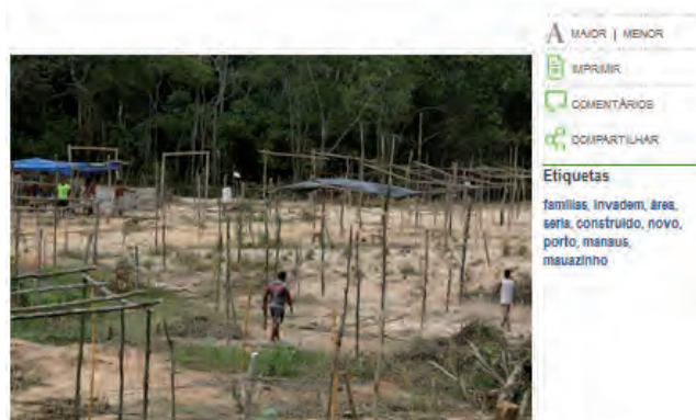
As primeiras armações dos barracos estão erguidas no local invadido (Euzivaldo Queiroz)
