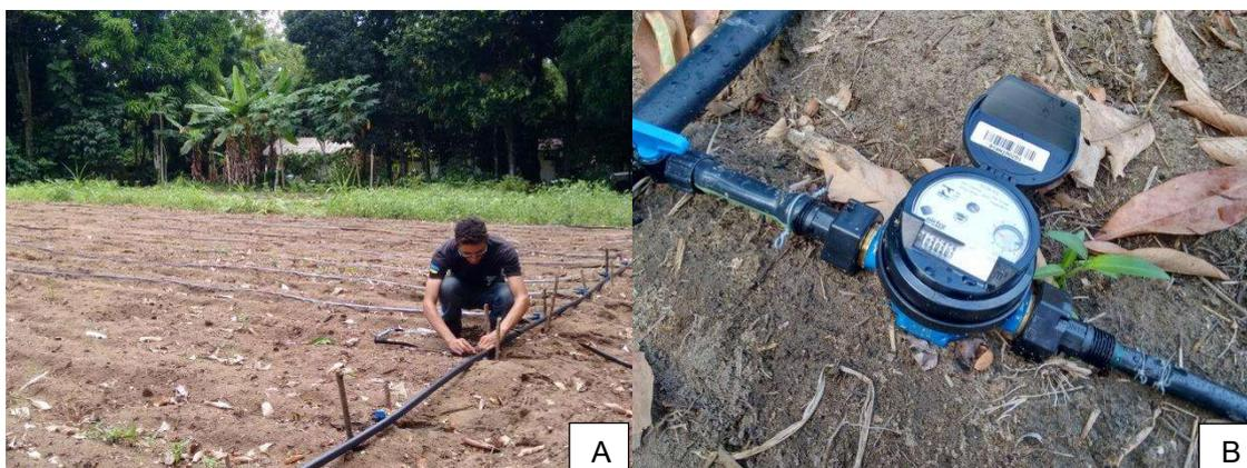
**Figura 7.** Montagem do sistema de irrigação (A) e hidrômetro em detalhe (B).
