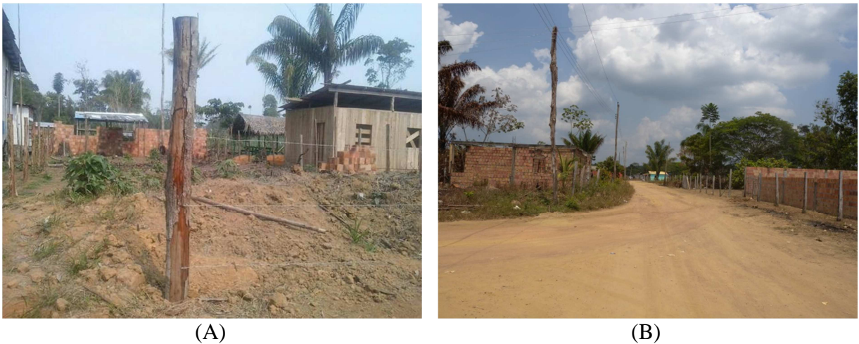
Figura 18. Dinâmica de uso e cobertura da terra: (A) Comunidade rural e (B) Construção de novos empreendimentos. (Fonte: (A) http://am.mgfimoveis.com.br/venda-am-manaus-vendo-terreno-proximo-cidade-universitaria-iranduba-41392800 e (B) o próprio autor)
