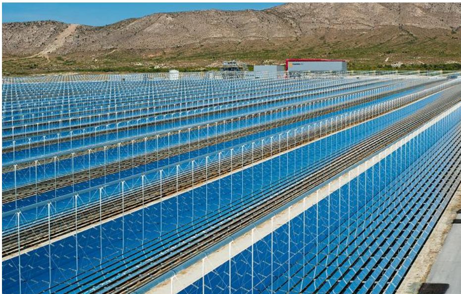
Σχήμα 1.16: Ηλιακός σταθμός τεχνολογίας Fresnel ισχύος 30MW, της εταιρείας Novatec Solar στην Ισπανία [31]
