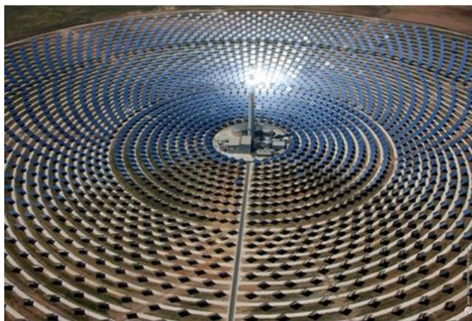
Σχήμα 1.13: Ηλιακός σταθμός με κεντρικό δέκτη στην πόλη Φουέντες της Ανδαλουσίας, στην Ισπανία συνολικής επιφάνειας 480 στρεμμάτων, με 2650 ηλιοστάτες και παραγόμενη ισχύ 19,9MW [30]
