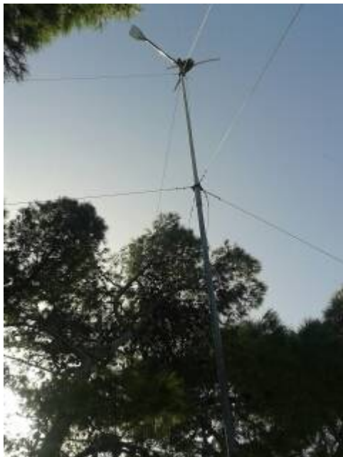
Εικόνα 2.15 Η ανεμογεννήτρια που είναι εγκατεστημένη στο «Μελτέμι»
