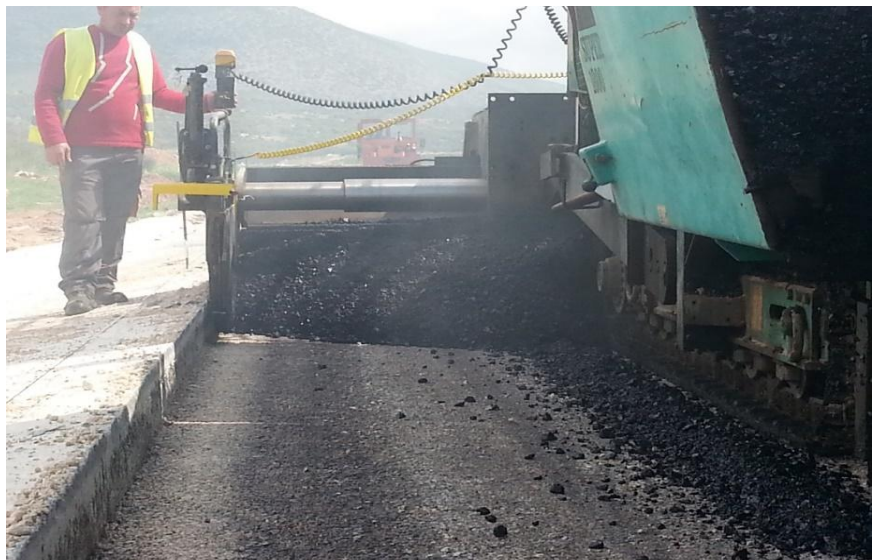
Εικόνα 3.17: Διαδικασία τελικής διάστρωσης ασφαλτοσκυροδέματος με χρήση ράμματος καθοδήγησης
