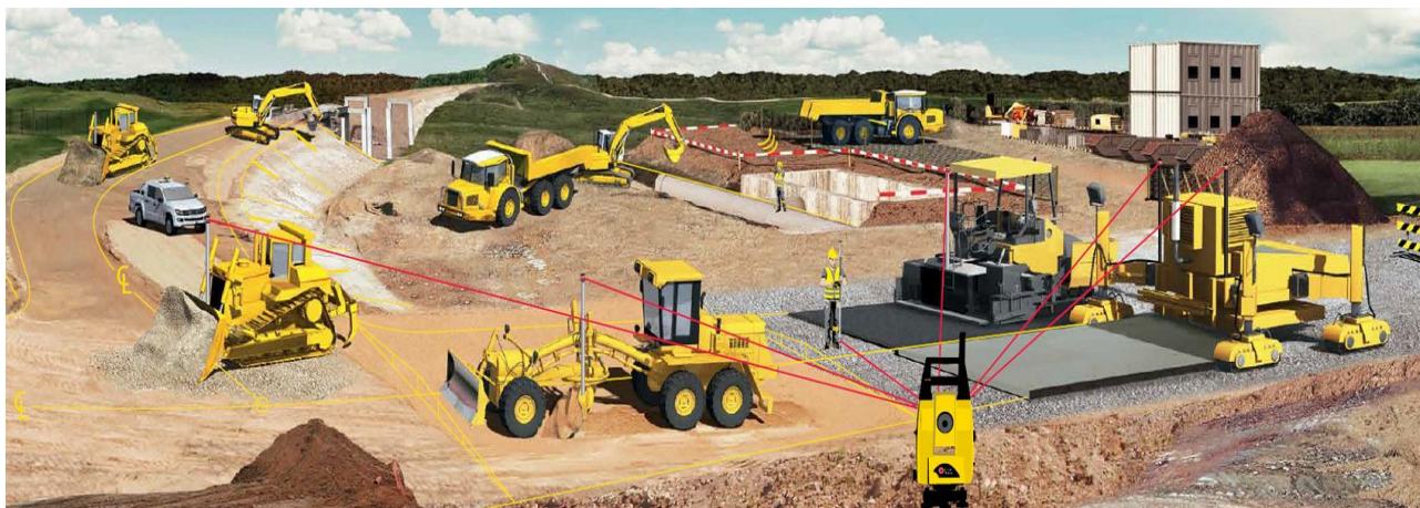
Εικ.2.26: Εφαρμογή μεθόδου ΔΚΜ συνολικά σε εργοτάξιο (Πηγή : http://www.leica-geosystems.us/en/Leica-iCON_97929.htm )
