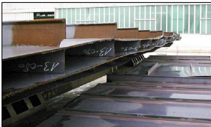
Εικόνα 2.1 : Παραμορφωμένα deck panels επιβατηγού πλοίου που συγκολλήθηκαν με συγκόλληση τόξου. [26]
