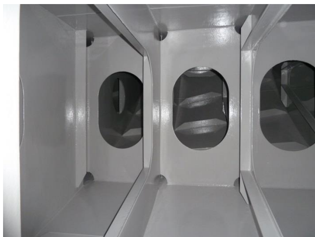
Εικόνα 3.4 : Τελική όψη δεξαμενής έρματος με προστατευτική επικάλυψη .[47]
