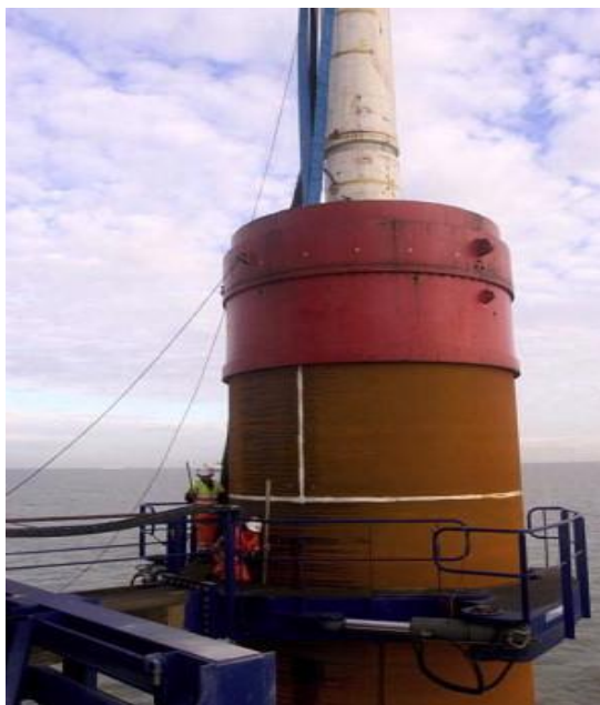
Σχήμα 5.3: Ειδικό σφυρί έμπηξης.
