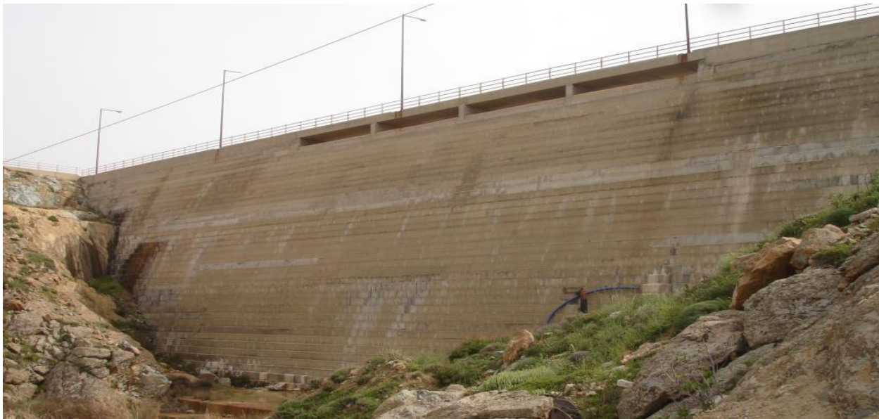
Εικόνα (3): Φράγμα Μαραθιάς Μυκόνου, άποψη από την κατόντη πλευρά
