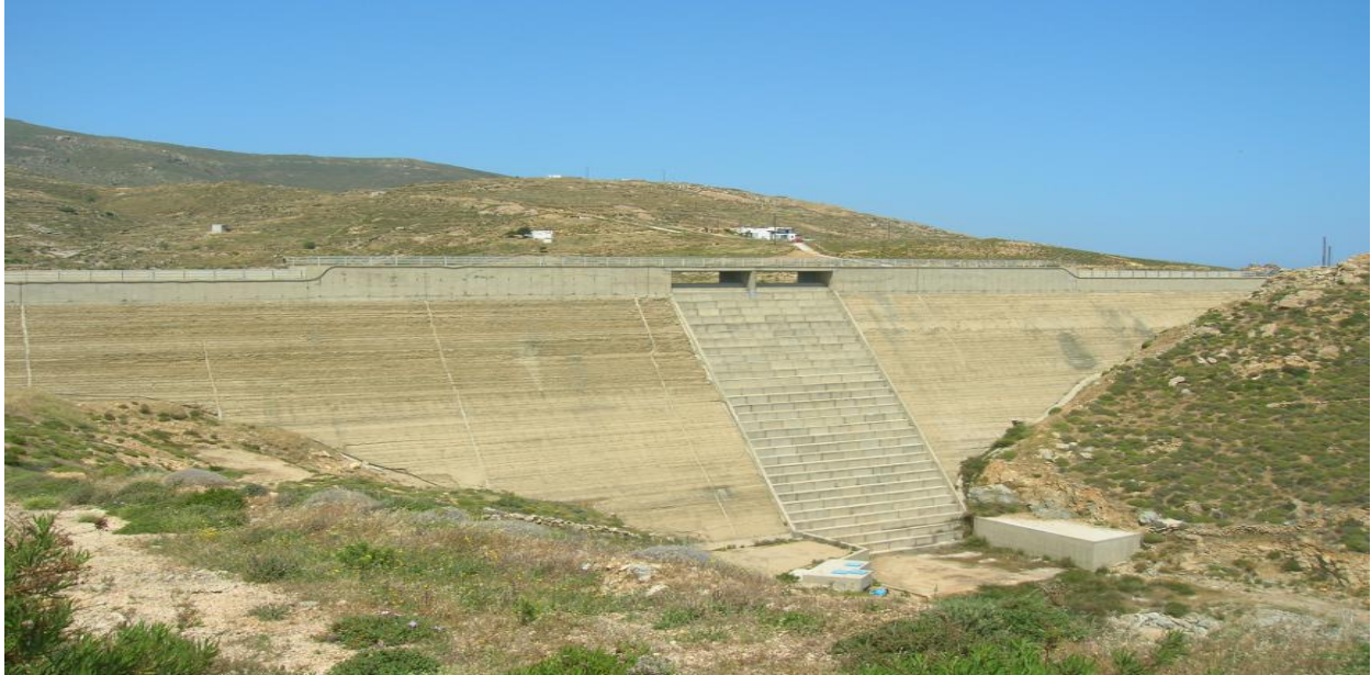
Εικόνα (4): Φράγμα Στενό Σερίφου, άποψη από το δεξί κατάντη πρανές
