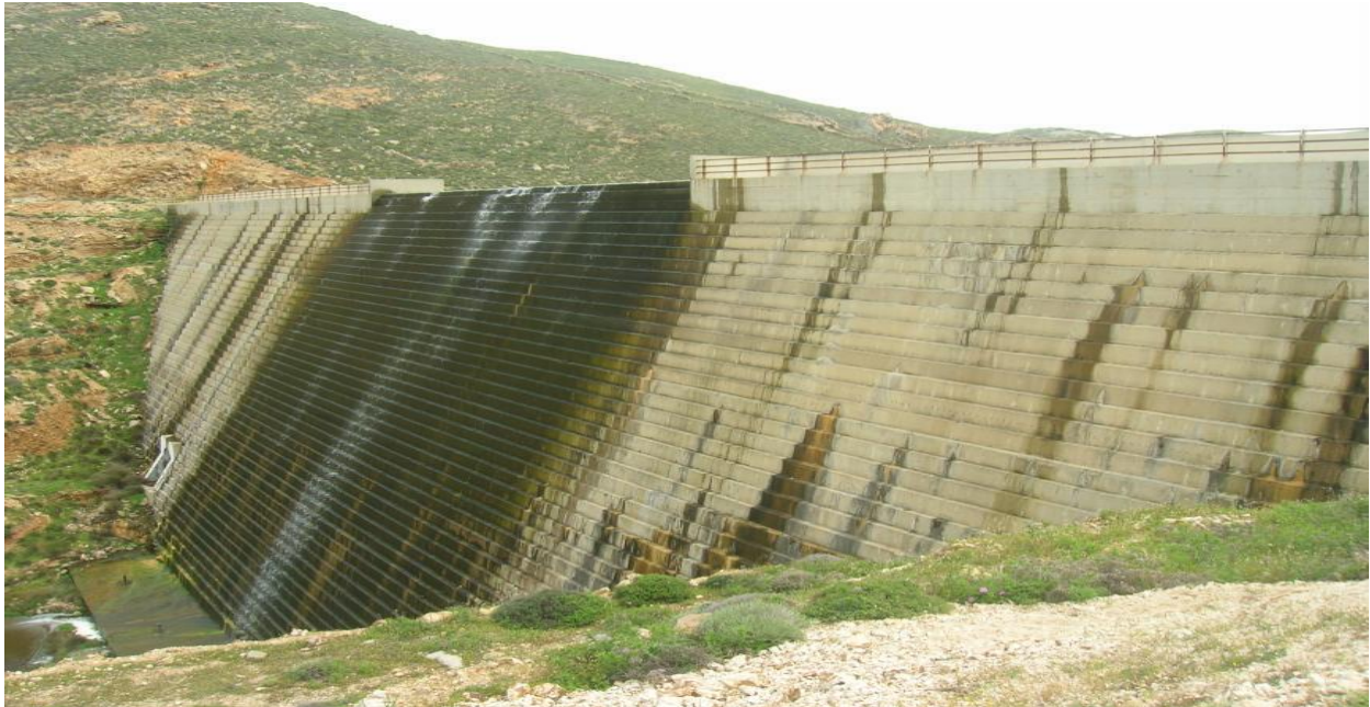
Εικόνα (2): Φράγμα Άνω Μεράς Μυκόνου, άποψη από το αριστερό κατόντη πρανές
