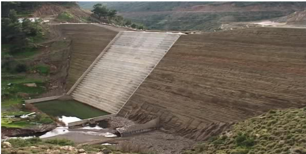
Εικόνα (5): Φράγμα Κόρης Γεφύρι Χίου, άποψη από το αριστερό κατάντη πρανές
