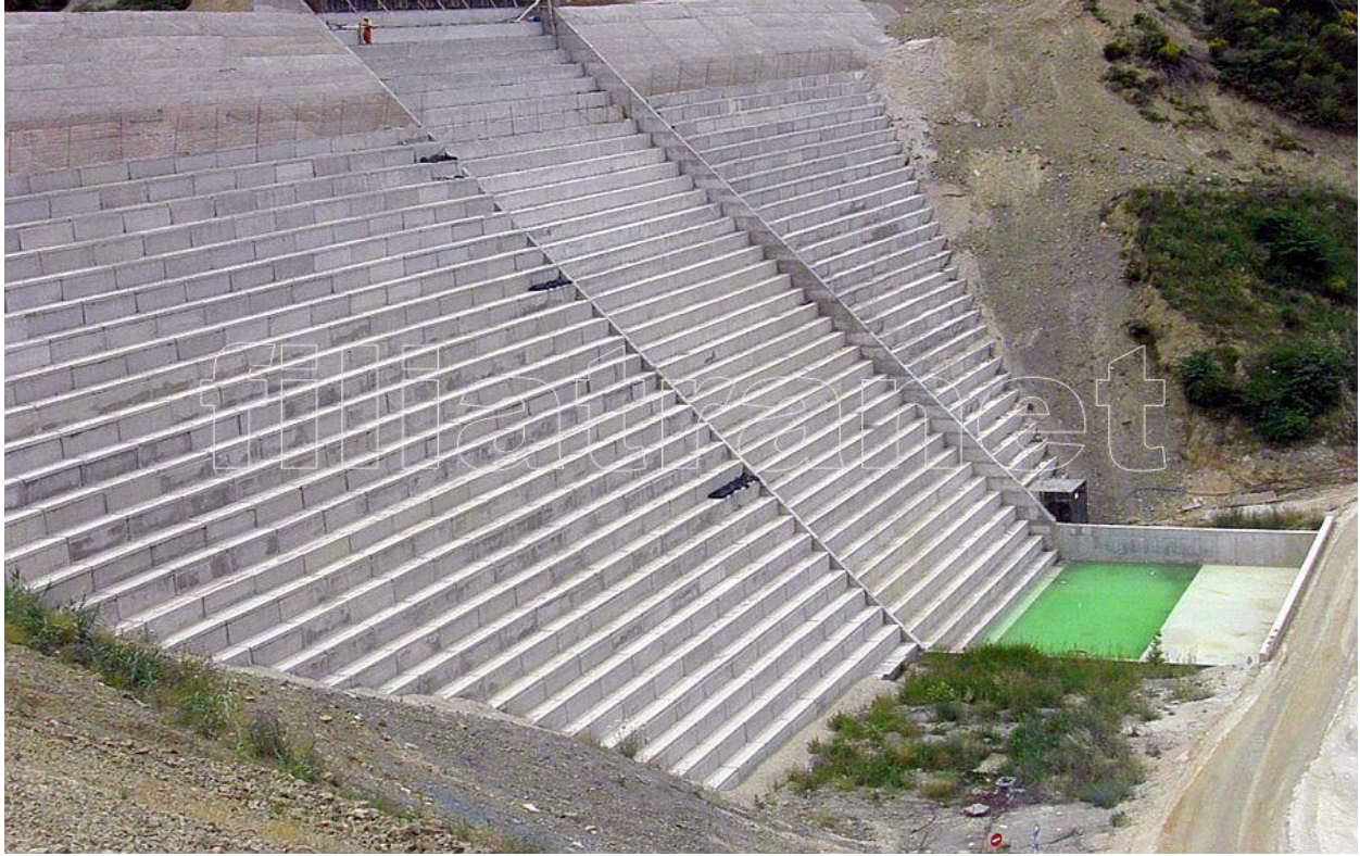
Εικόνα (7): Φράγμα Φιλιατρών Μεσσηνίας, άποψη απο το δεξι κατάντι πρανές
