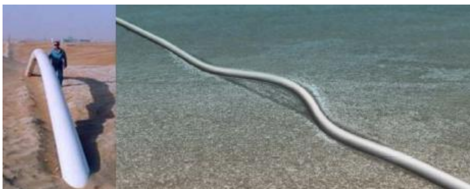
Σχήμα 1-3. Καθολικός λυγισμός υπόγειου μεταλλικού αγωγού [ http://www.advancepipeliner.com ]
