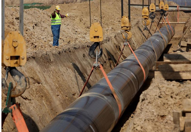
Σχήμα 1-1. Τοποθέτηση μεταλλικού αγωγού σε όρυγμα [ http://www.constructionweekonline.com ]
