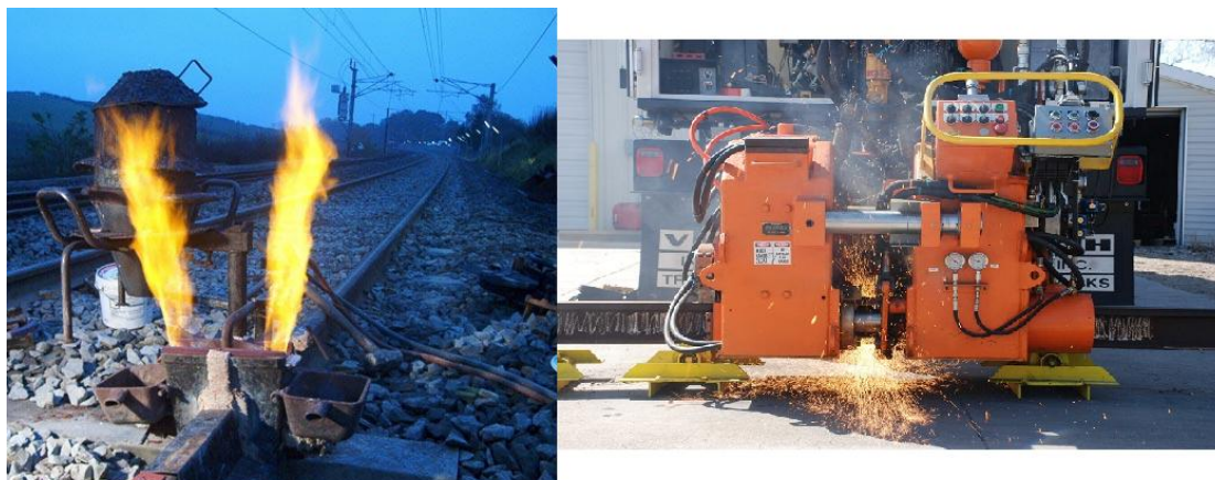
Εικόνα 4.3: Αλουμινοθερμική συγκόλληση (αριστερά) και μηχανήμα αυτογενούς συγκόλλησης (δεξιά)
