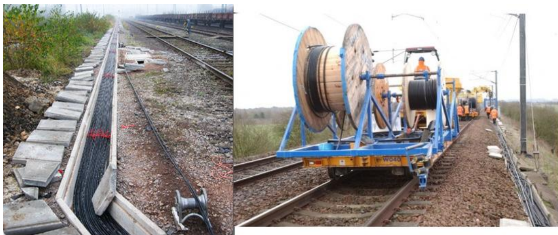
Εικόνα 4.9: Φρεάτια καλωδιώσεων σηματοδότησης (αριστερά) και διαδικασία τοποθέτησης (δεξιά) ( www.kvg-germany.de )
