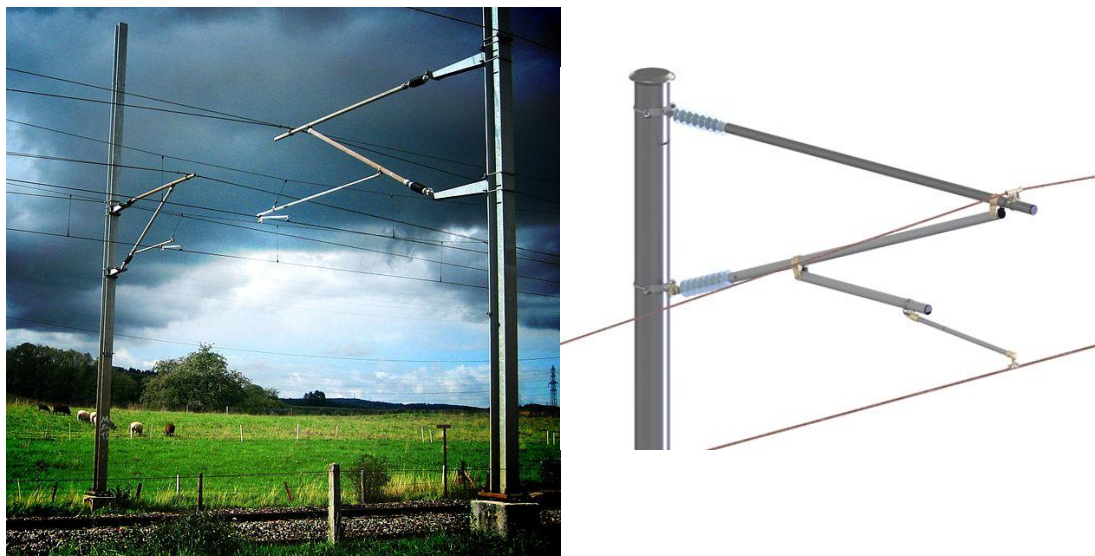
Εικόνα 4.7: Στήριξη κονσόλας σε στύλο σε διπλή σιδηροδρομική γραμμή (αριστερά) και λεπτομέρεια κονσόλας (δεξιά) ( en.wikipedia.org , railway-technology.com )
