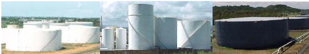
Σχήμα 7.12: Τυπικές δεξαμενές αποθήκευσης πετρελαιοειδών διαφορετικών λόγων ακτίνας προς ύψος
