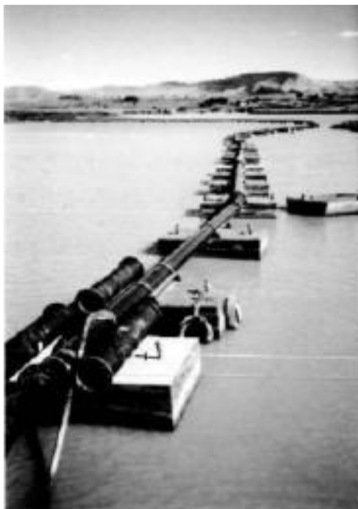
Εικόνα 6-26:Μεταφορά φερτών υλών με αγωγό.(Basson & Rooseboom, Dealing with reservoir sedimentation-dredging, 1999)
