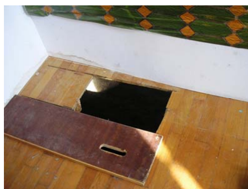
Εικόνα 3. 4: Άνοιγμα που οδηγεί στο υπόγειο
