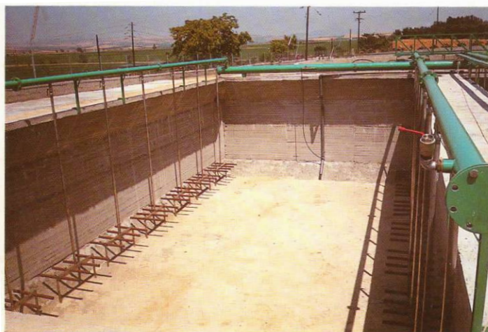
Σχήμα 2.4 : Δεξαμενή αερισμού με διάχυση αέρα
