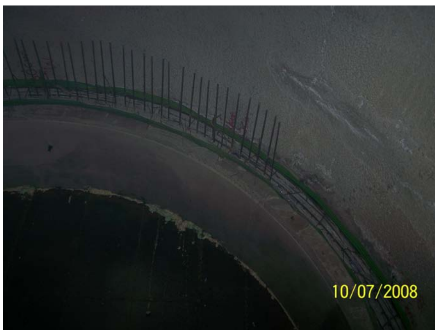
Εικόνα 11.5: Αγκύρια περιμετρικά του θόλου της σήραγγας διπλής τροχιάς. (Φωτογραφικό Αρχείο Αττικό Μετρό)
