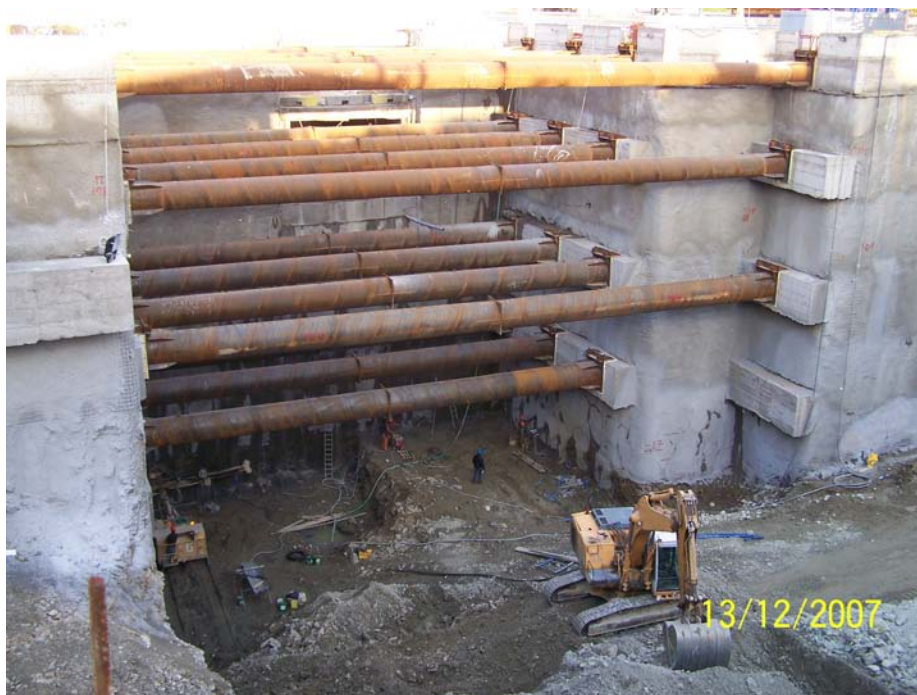
Εικόνα 9.2: Τοποθέτηση τεσσάρων σειρών σωληνωτών αντηρίδων στο τμήμα της εκσκαφής που γειτνιάζει με τον Ι.Ν. Ευαγγελίστριας. Η πρώτη σειρά έχει τοποθετηθεί επί του κεφαλόδεσμου. (Φωτογραφικό Αρχείο Αττικό Μετρό)
