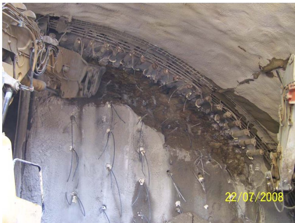
Εικόνα 10.5: Διάνοιξη 2 ης Φάσης. (Φωτογραφικό Αρχείο Αττικό Μετρό)
