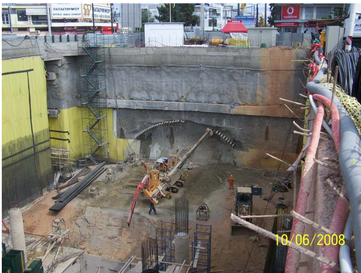
Εικόνα 10.1: Διαδικασία τοποθέτησης δοκών προπορείας στο θόλο του υπόγειου τμήματος του Σταθμού. (Φωτογραφικό Αρχείο Αττικό Μετρό)
