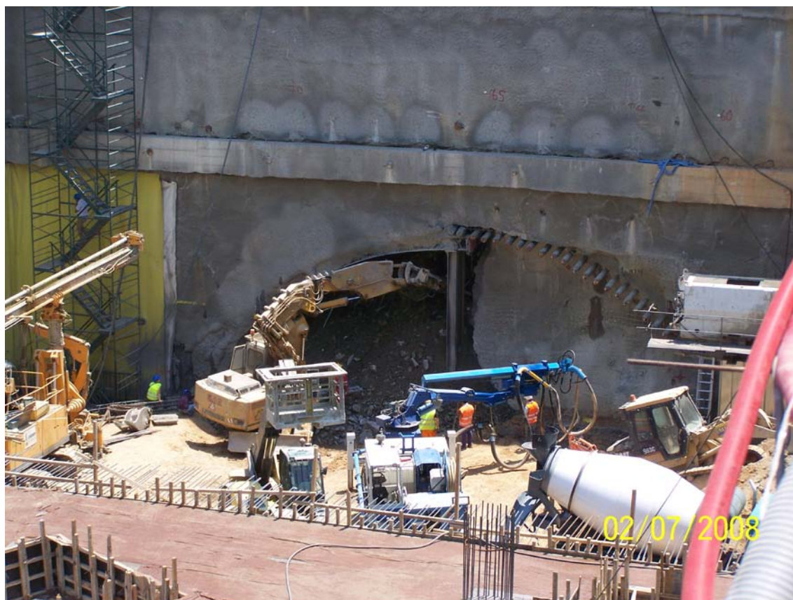
Εικόνα 10.3: Διάνοιξη 1 ης φάσης. (Φωτογραφικό Αρχείο Αττικό Μετρό)
