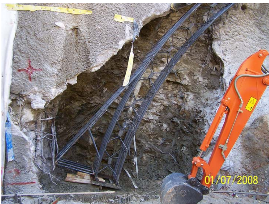
Εικόνα 11.7: Τοποθέτηση πεδילוδοκού (elephant foot). (Φωτογραφικό Αρχείο Αττικό Μετρό)
