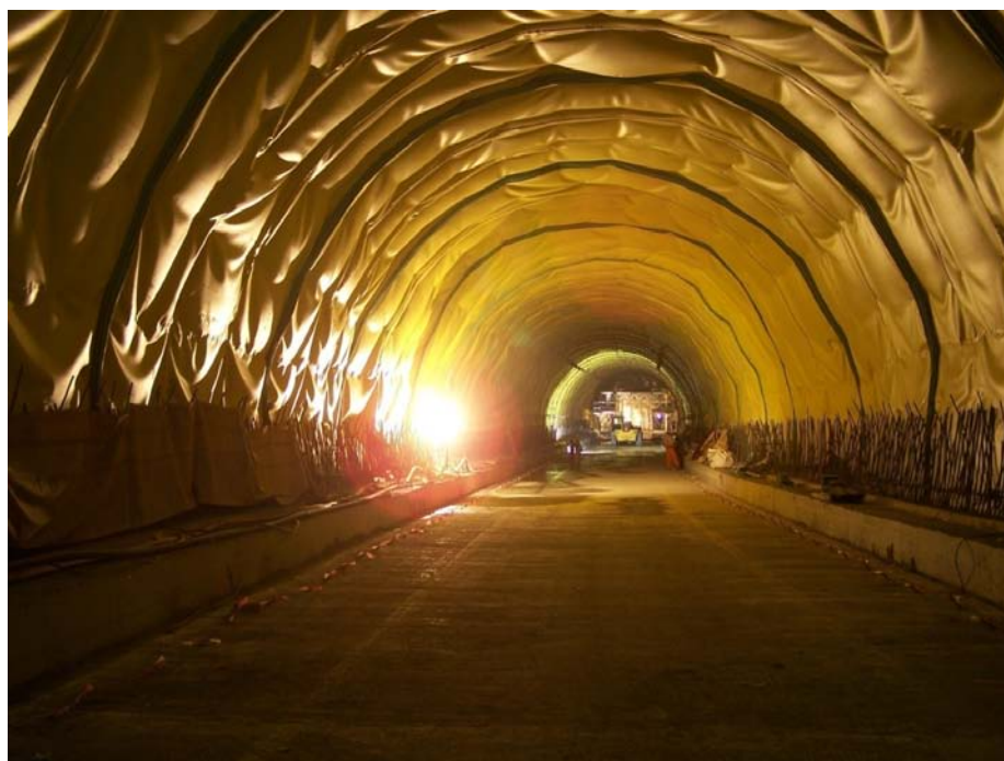
Εικόνα 11.3: Σύστημα υδατοστεγάνωσης στη σήραγγα διπλής τροχιάς του έργου. (Φωτογραφικό Αρχείο Αττικό Μετρό)
