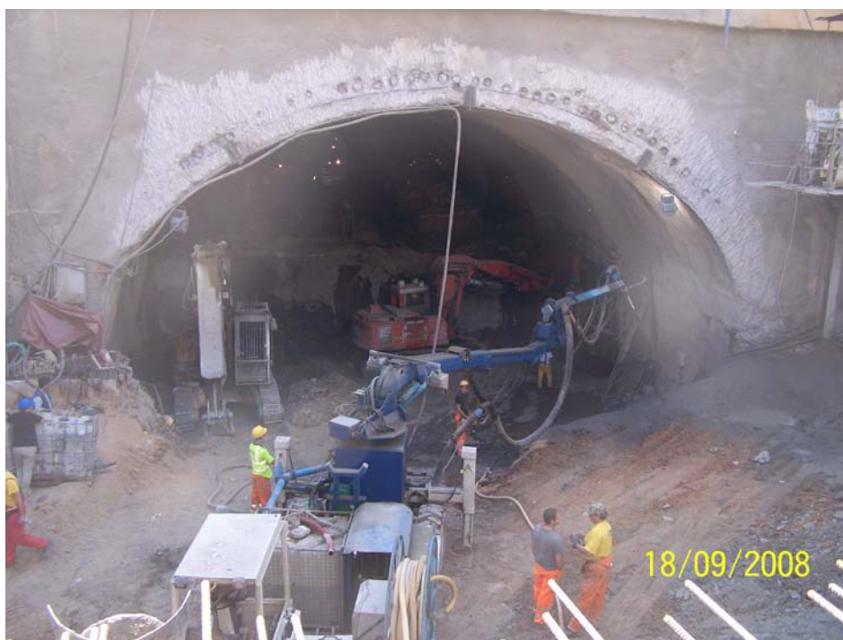
Εικόνα 10.6: Εκσκαφή βαθμίδας (3 η Φάση). (Φωτογραφικό Αρχείο Αττικό Μετρό)
