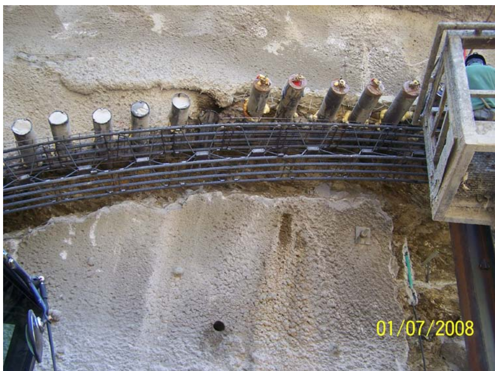
Εικόνα 11.8: Δοκοί προπορείας (forepoling). (Φωτογραφικό Αρχείο Αττικό Μετρό)
