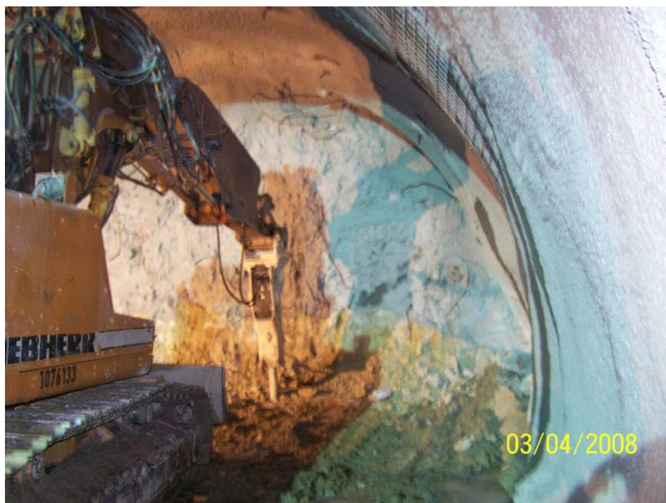
Εικόνα 11.2: Μηχανικός εκσκαφέας. (Φωτογραφικό Αρχείο Αττικό Μετρό)
