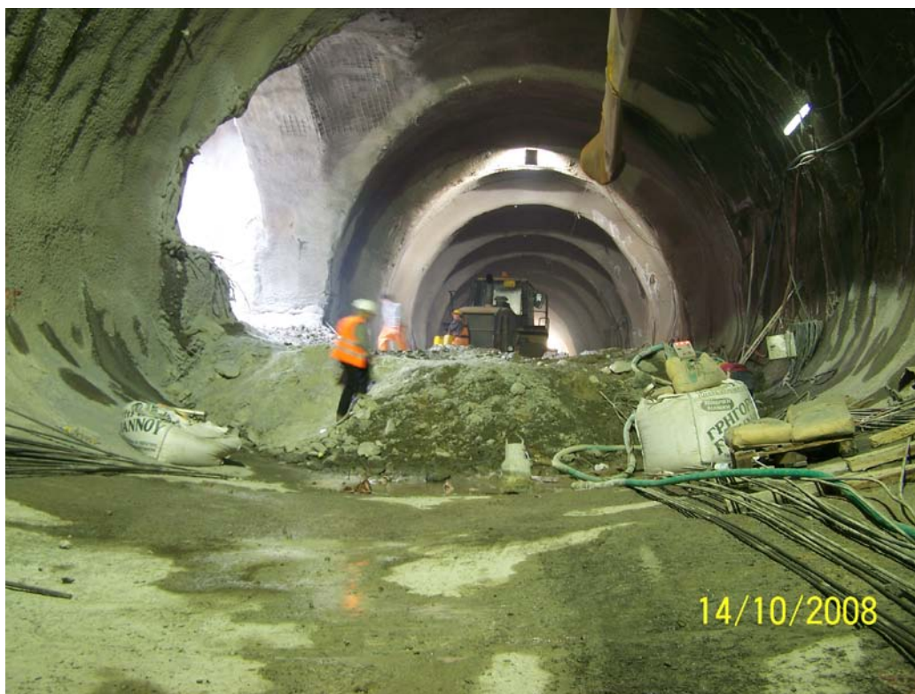
Εικόνα 11.9: Είσοδος από το φρέαρ πρόσβασης στη σήραγγα διπλής τροχιάς. (Φωτογραφικό Αρχείο Αττικό Μετρό)
