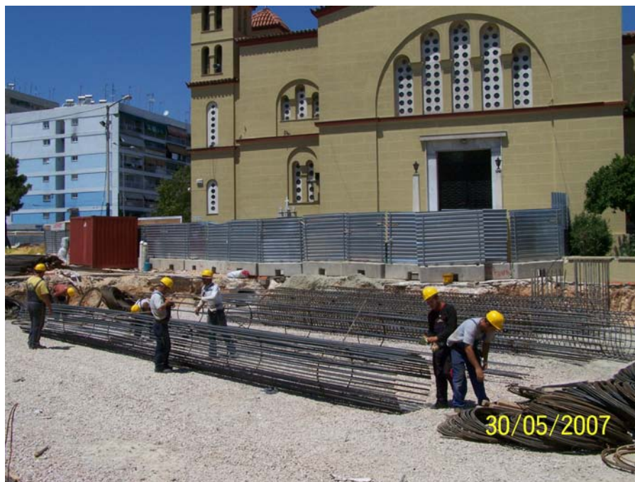
Εικόνα 9.4: Αγκύρια και δομικό πλέγμα πριν την τοποθέτησή τους (στο φόντο ο Ι.Ν. Ευαγγελίστριας). (Φωτογραφικό Αρχείο Αττικό Μετρό)
