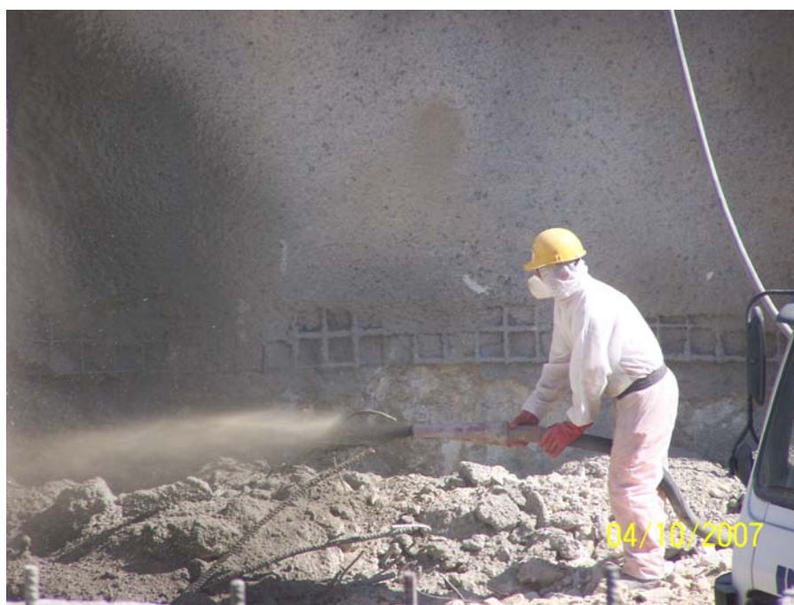
Εικόνα 9.3: Εφαρμογή εκτοξευόμενου σκυροδέματος. Διακρίνεται το δομικό πλέγμα. (Φωτογραφικό Αρχείο Αττικό Μετρό)
