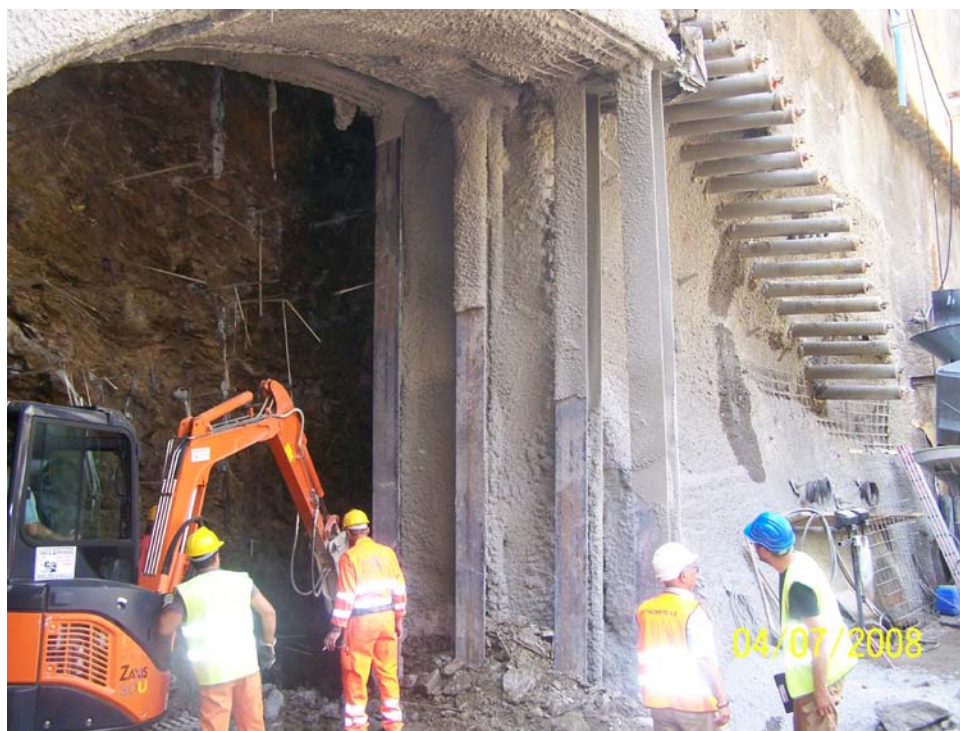
Εικόνα 10.4: Προσωρινό ενδιάμεσο τοίχωμα. Διακρίνονται οι ηλώσεις υαλοϊνών. (Φωτογραφικό Αρχείο Αττικό Μετρό)
