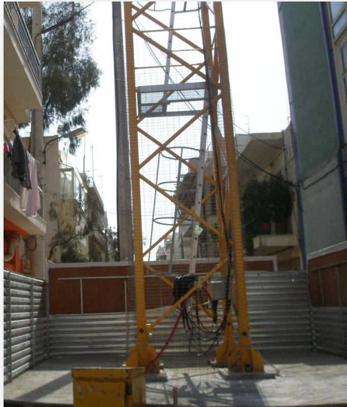
Εικόνα 10.1: Γερανός στη βορειοδυτική πλευρά του σταθμού (ΑΤΤΙΚΟ ΜΕΤΡΟ Α.Ε.)
