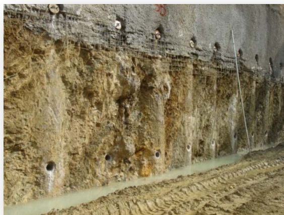
Εικόνα 10.3: Αντιστήριξη πασσάλων με προεντεταμένα αγκύρια και εκτοξευόμενο σκυρόδεμα οπλισμένο με χαλύβδινο πλέγμα, στο σταθμό "Ανθούπολη" (ΑΤΤΙΚΟ ΜΕΤΡΟ Α.Ε.)
