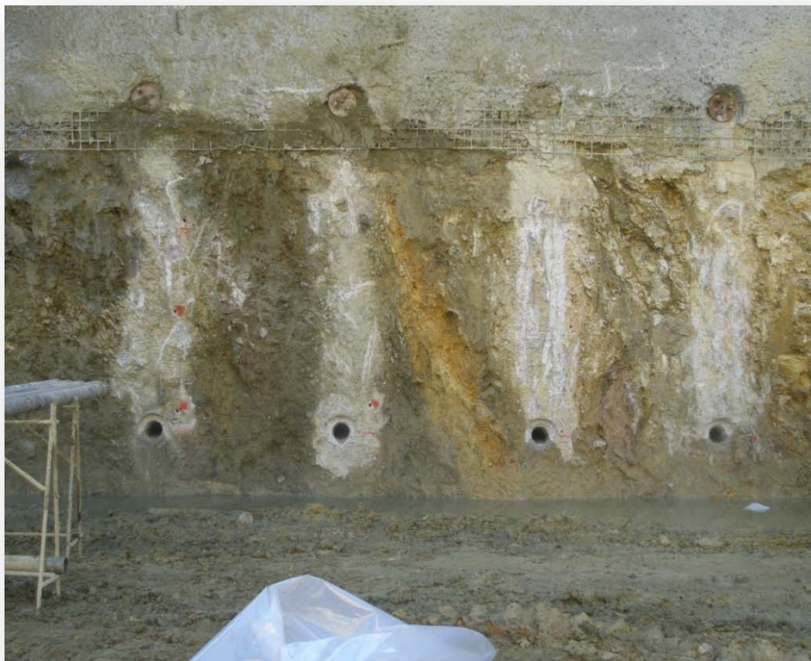
Εικόνα 8.1: Ρήγμα στο χώρο του σταθμού (ΑΤΤΙΚΟ ΜΕΤΡΟ Α.Ε.)
