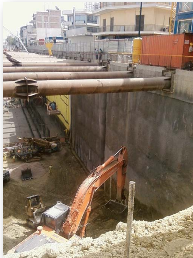
Εικόνα 4: Η μέθοδος “cut and cover” στο σταθμό “Ανθούπολη”. Διακρίνονται οι αντηρίδες και ο κεφαλόδεσμος (ΑΤΤΙΚΟ ΜΕΤΡΟ Α.Ε.).
