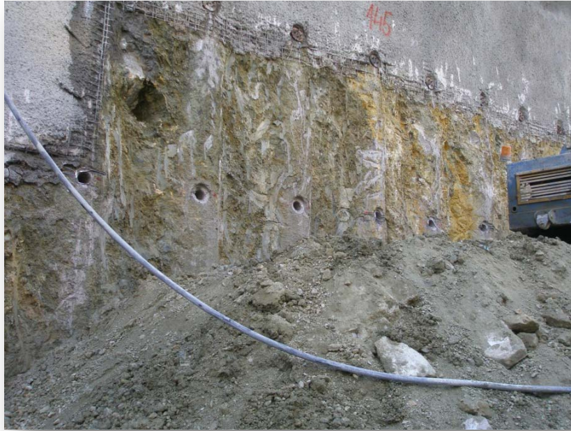
Εικόνα 3: Προσωρινή αντιστήριξη στο σταθμό. Διακρίνεται το ρήγμα και η εναλλαγή από τους σχηματισμούς της σειράς των Αθηναϊκών Σχιστολίθων στους νεογενείς μαργαϊκούς σχηματισμούς (ΑΤΤΙΚΟ ΜΕΤΡΟ Α.Ε.).
