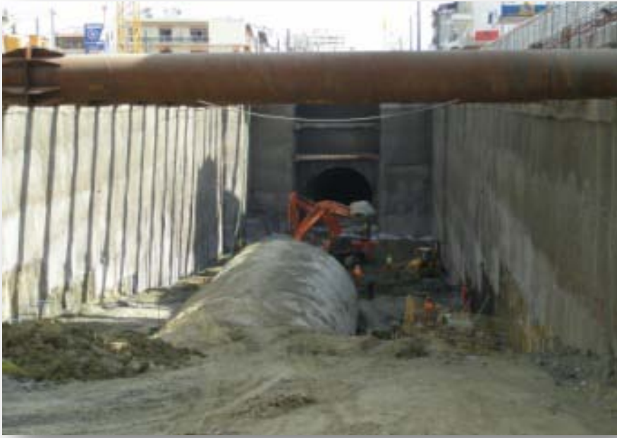
Εικόνα 5: Αποκάλυψη της σήραγγας που διανοίχτηκε με μηχανήμα OFS παλαιότερα (ΑΤΤΙΚΟ ΜΕΤΡΟ Α.Ε.).
