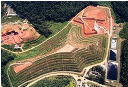
Figura 3: Vista aérea do aterro sanitário de Joinville
