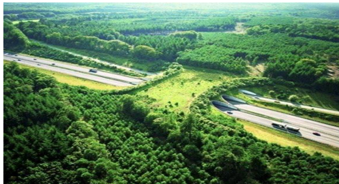
Figura 4 – Viaduto integrado à paisagem localizado na Holanda que serve como passagem de fauna
