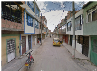
Figura 39: Estrato 2 – Vias e calçadas estreitas, edificações geminadas.
