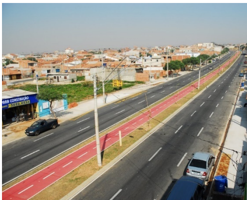
Figura 71: Ciclovia conectando o Centro ao extemo Norte com nenhuma integração com o entorno.
