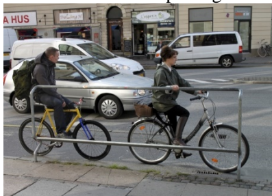
Figura 26: Apoio para pés nos cruzamentos de Copenhague .
