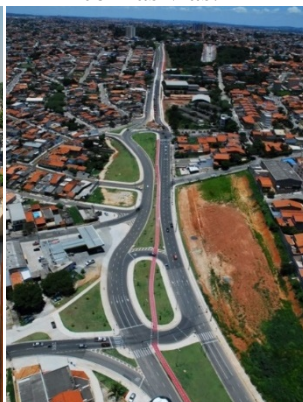
Figura 72: Ciclovia sobre o canteiro central. Conflitos nos cruzamentos com as vias.
