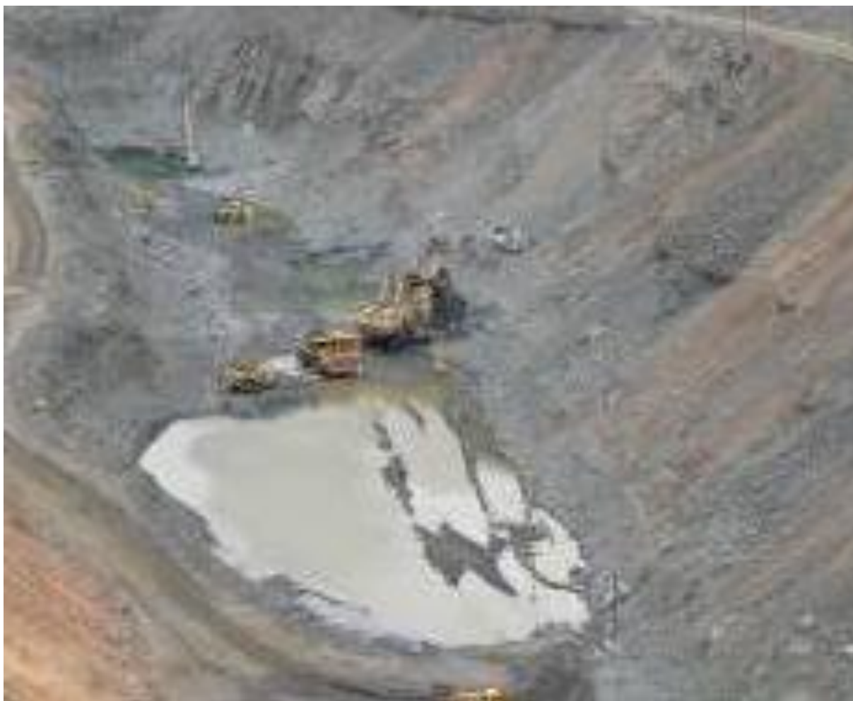
Рис. 1 – Послойная проходка траншеи механической лопатой
