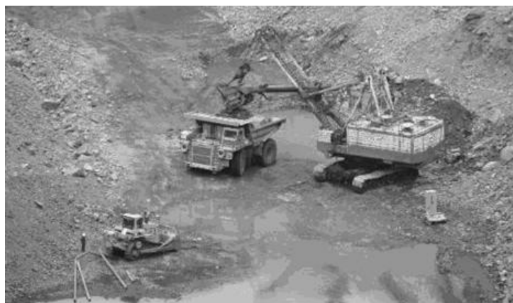
Рис. 3 – Послойная проходка траншеи механической лопатой
