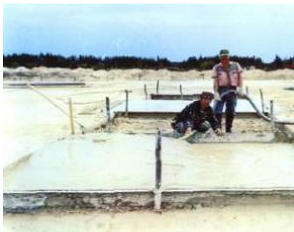
Рис. 5. Укладка гидроизолирующего раствора под будущим хранилищем ТРО-1 на объекте «Вектор»
