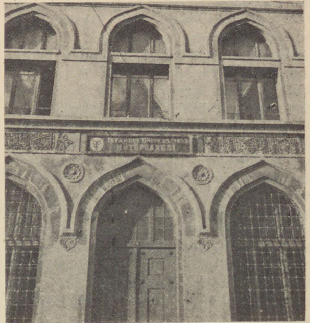
Üniversite Kitaplığının cephesinden Une partie de la façade de la Bibliothèque.
