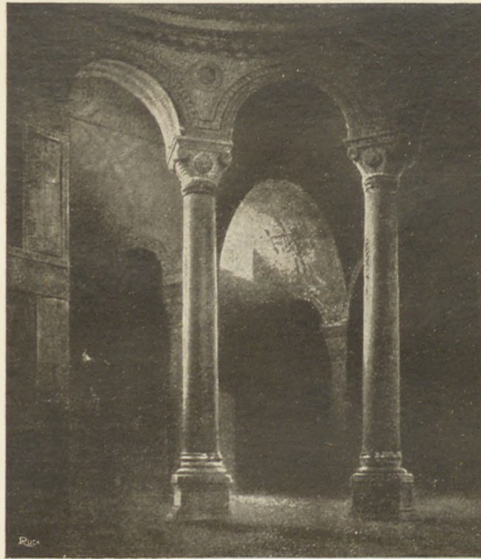
LES GRANDES COLONNES DE PORPHYRE Ces merveilleux monolithes de marbre rouge proviendraient du Temple du Soleil, à Baalbeck (Syrie).
