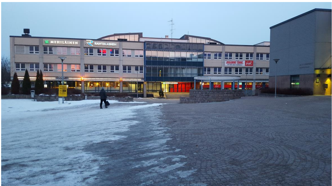
Kuva 2 Liiketalo Myyrinraitin pääsisäänkäynnin julkisivu [10]
