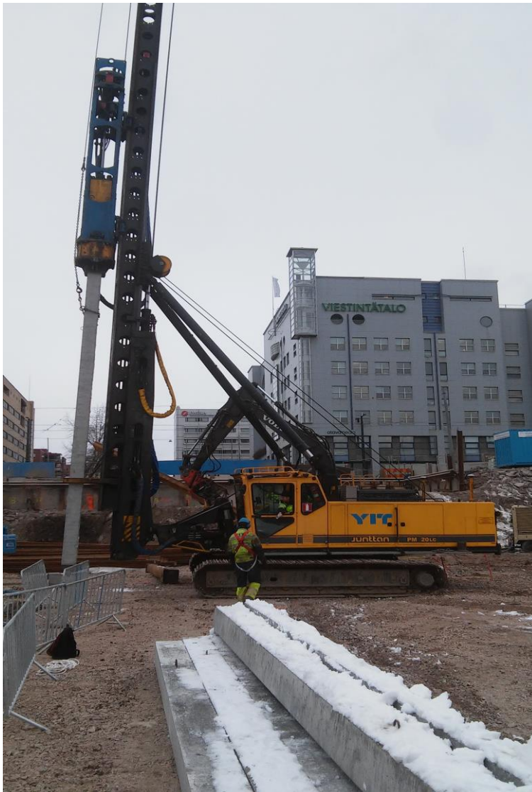
KUVA 4. Junttan PM 20LC varustettuna 5tn vaijeriripusteisella pudotusjärkeleellä
