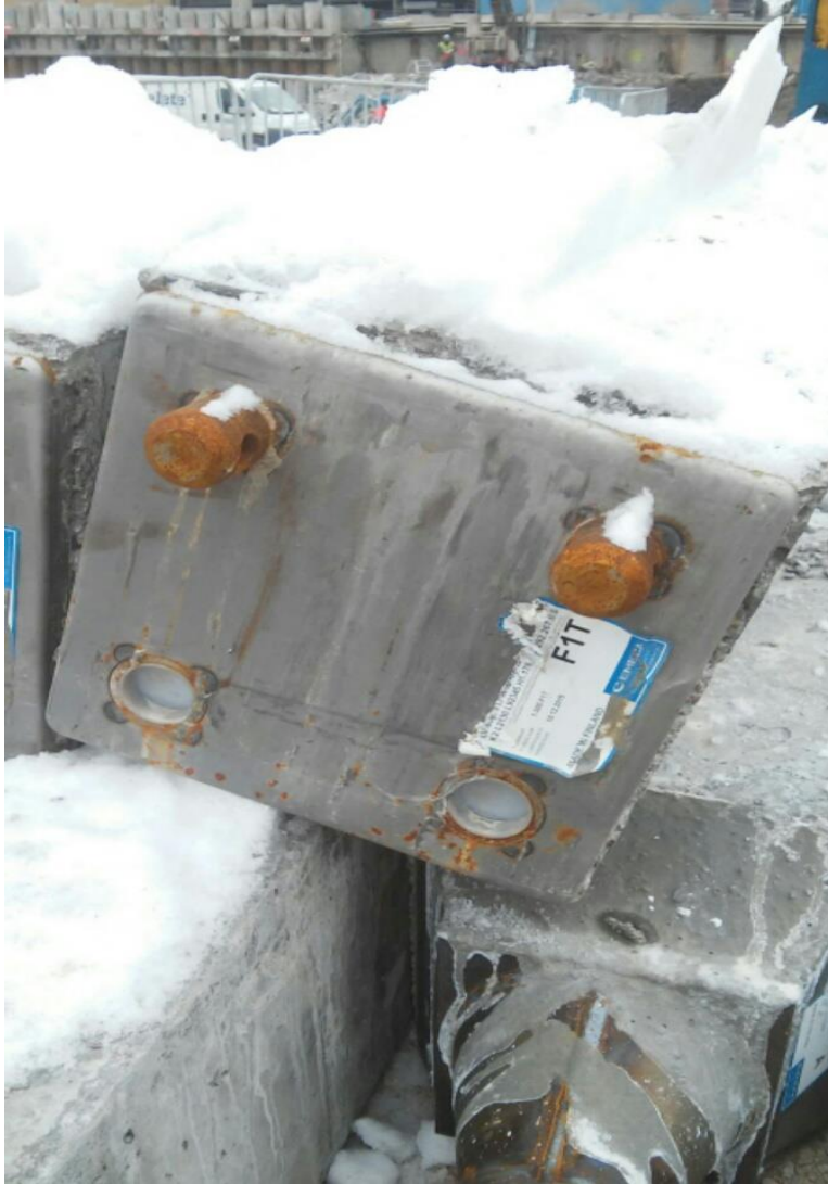
KUVA 2. Paalujatkos 350'350 mm teräsbetonipaaluissa
