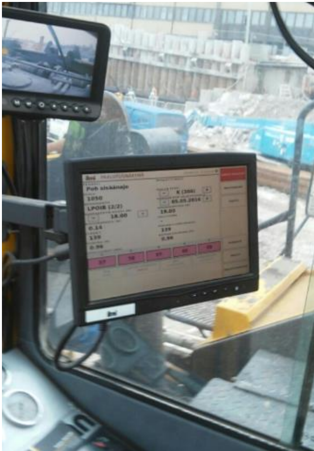
KUVA 11. Lyöntipaalutus koneen seurantanäyttö, josta ilmenee esimerkiksi lyöntien määrä ja paalun painuminen
