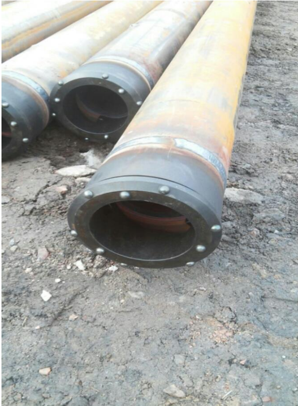
KUVA 7. Avarrinkruunu paaluun hitsattuna
