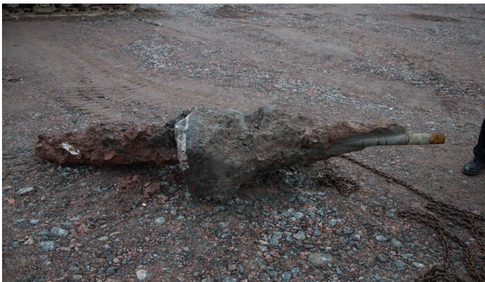
KUVA 13. Injektoitu ja ylöskaivettu mikropaalu (Arend Oudman, 2015)
