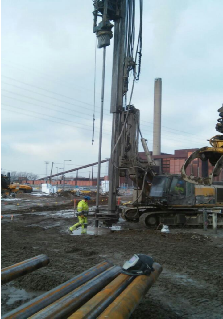
KUVA 6. Porapaalutuskalustoa. Uppovasara ja keskinen porausmenetelmä
