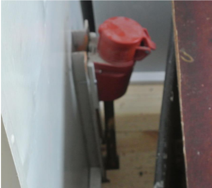
Kuva 11. Vanha lieden syöttö muutettiin 3-vaihepistorasiaksi.
