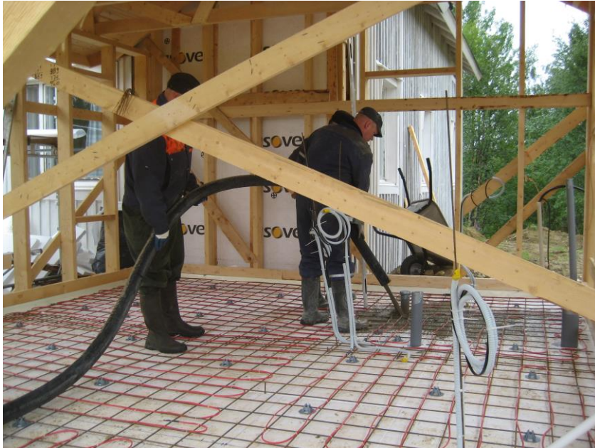
Kuva 13. Lattialämmityskaapelit asennettuna lattiavaluun.
