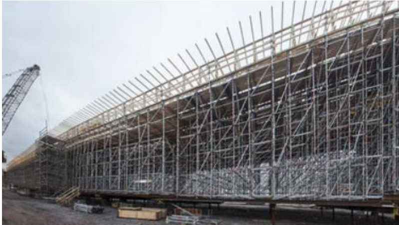
Kuva 3. Pasilan sillan terästukelineet [13.]
