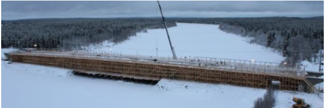
Kuva 2. Kaukosen sillan puiset tukitelineet Kittilässä [1.]
