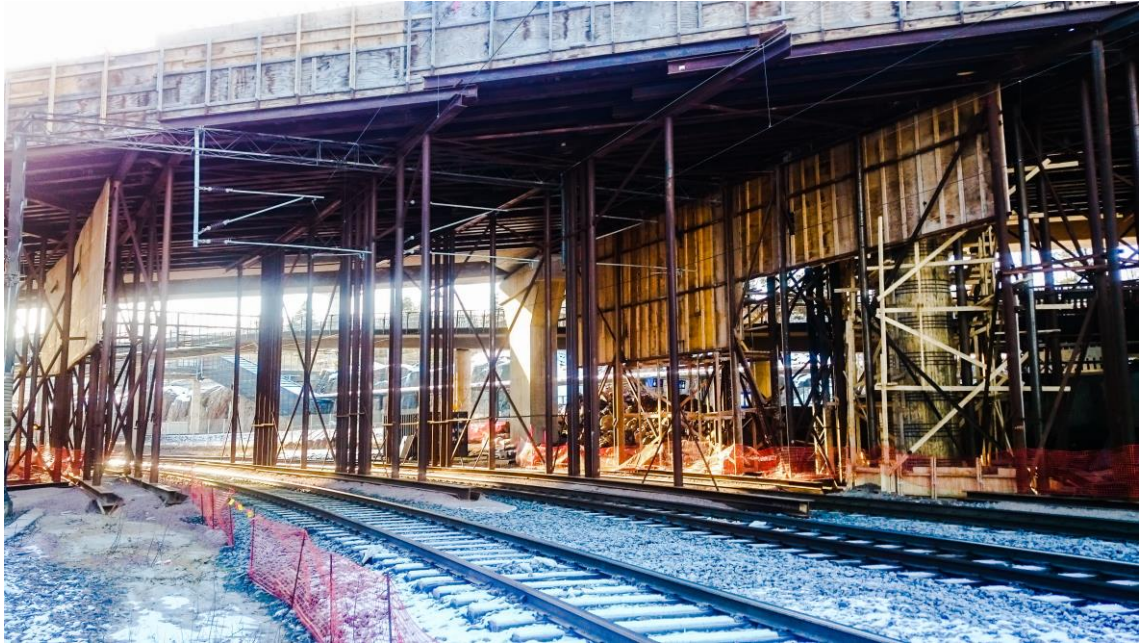
Kuva 12. Ratatyöalue on erotettu suoja-aidalla ja ylikulkukohtien kohdalta lippusiimalla. [15.]
