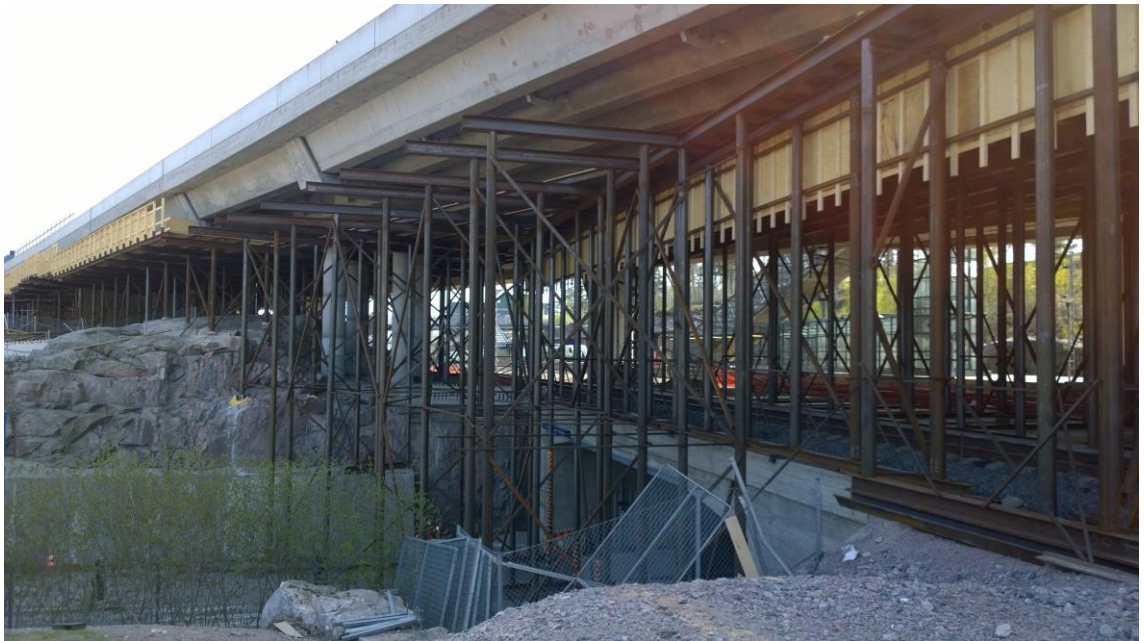
Kuva 11. Metsämäentien ylikulkusilta nro 3:n terästukitelineitä.
