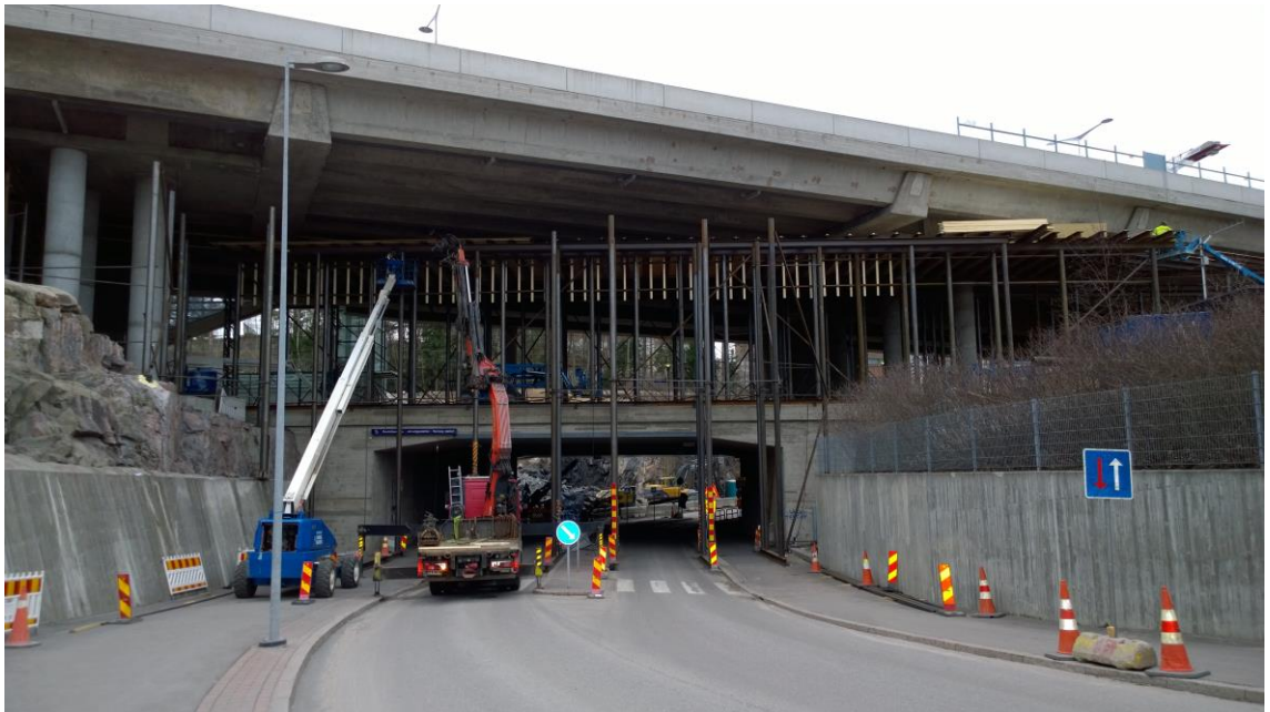
Kuva 15. Terästukitelineiden pystytystä tukivälille T4-T5. Purkuvaiheen nostopaikka ja liikennejärjestelyt ovat samanlaiset.
