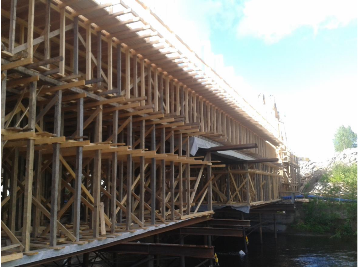
Kuva 7. Jumalniemen vesistösilta Kotkassa. Kuvassa näkyy suodatinkangas, joka estää esineiden tippumisen vesistöön.
