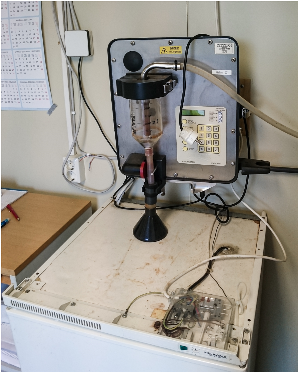
Kuva 17. Näytteenotossa käytettyä laitteistoa. Jääkaapin ylätasoon on tehty läpivienti vesinäytettä varten.
