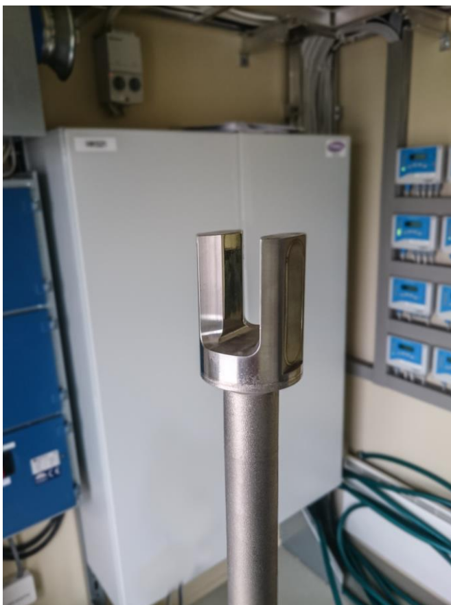
Kuva 14. Pitoisuusanturin haarukkakarri, joka upotetaan mitattavaan nesteeseen. Haarukka koostuu lähettimestä ja vastaanottamisesta.
