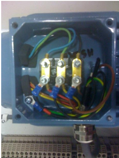
Kuva 22. Moottorin kolmiokytkentä
