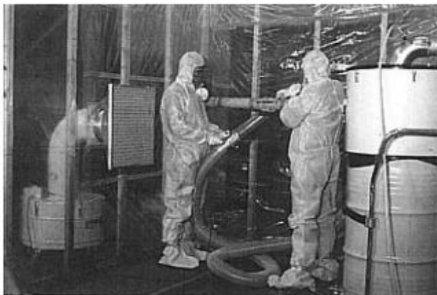
Bild 5. Asbestsanering med sektionerat utrymme med undertryck. (RT 08-10521 s.6)
