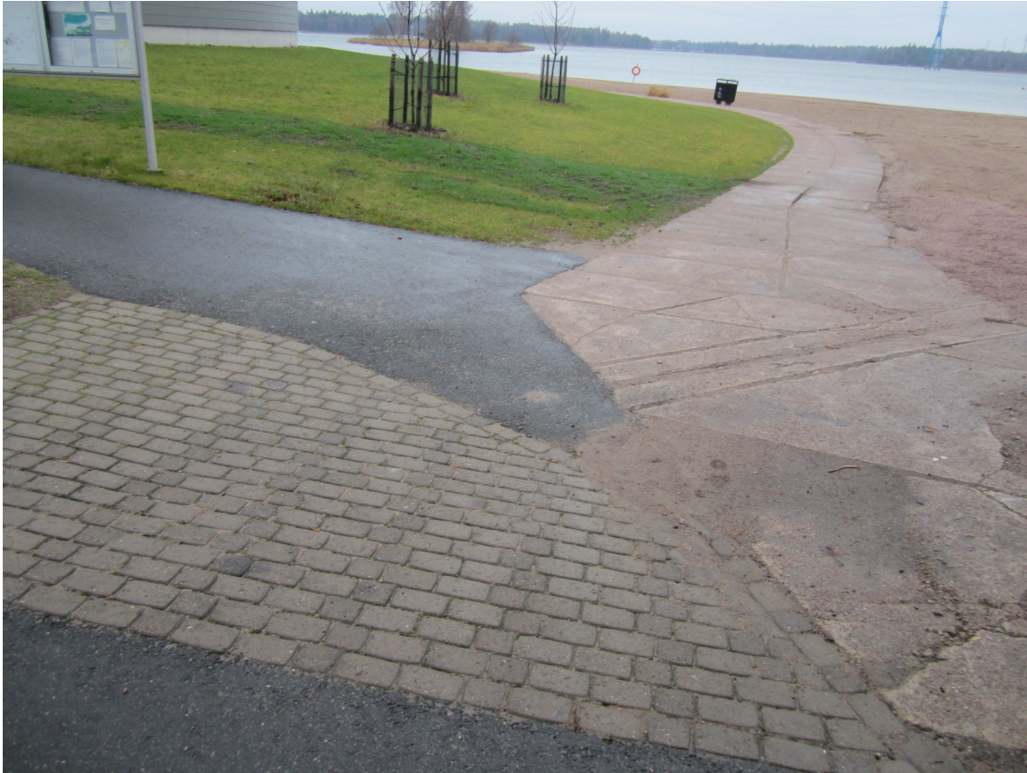
Figur 24. Sandstrands badstrand, exempel på ojämn, oregelbunden och instabil ytbeläggning vid förflyttningsväg från parkering ner till strand och omklädningsrum.
