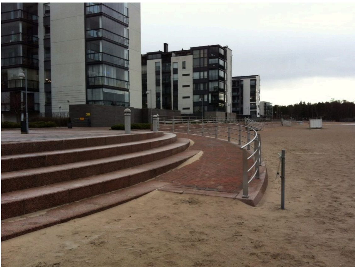
Figur 17. Solviks badstrand. En böjd ramp och trappor ner till stranden utgör tillgänglighetshinder, dessutom dålig belysning av både ramp och trappor.
